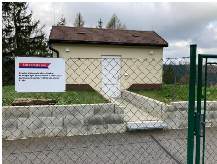
Obrázek 4.1 Místní vodojem (vlastní foto)
