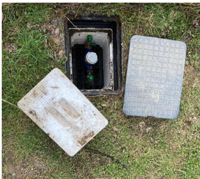
Obrázek 4.2 Přípojka pro pitnou vodu (vlastní foto)
