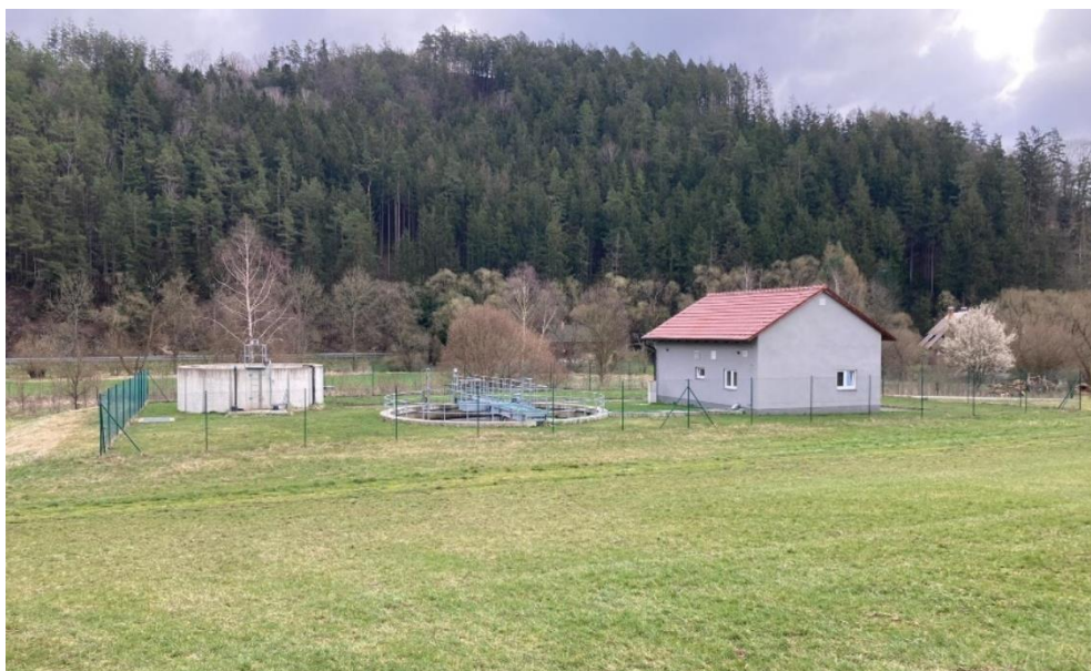
Obrázek 4.9 Čistička odpadních vod (vlastní foto)
