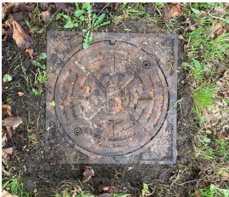
Obrázek 4.8 Kanalizační přípojka (vlastní foto)
