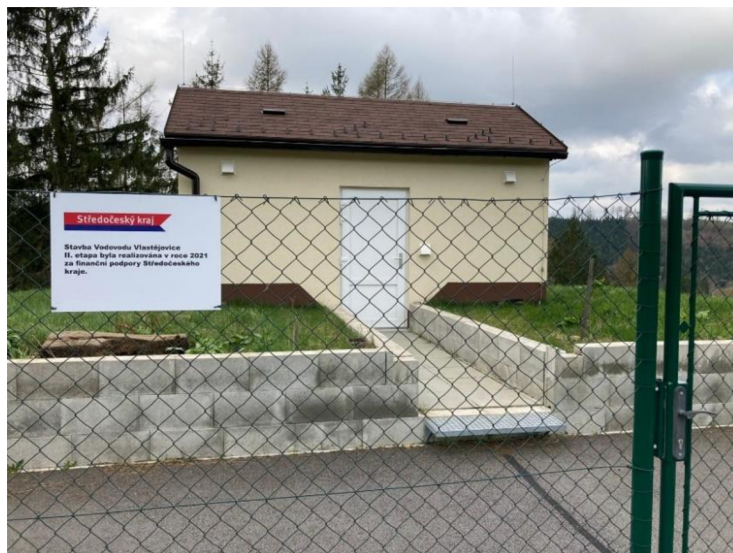
Obrázek 4.1 Místní vodojem (vlastní foto)
