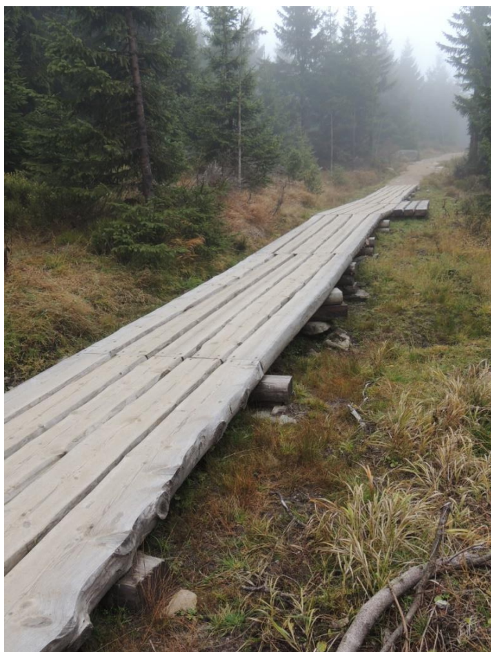
Obr. 29:Úsek povalového chodníku pod Petrovou boudou.
