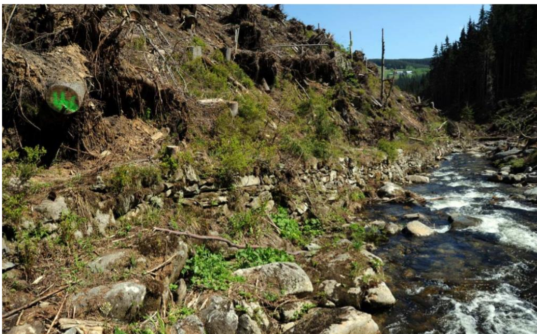
Obr. 24: Turistický chodník před rekonstrukcí, zničený polomem v červnu 2011 (projektová dokumentace rekonstrukce turistického chodníku „Pec pod Sněžkou – Zelený důl“).
