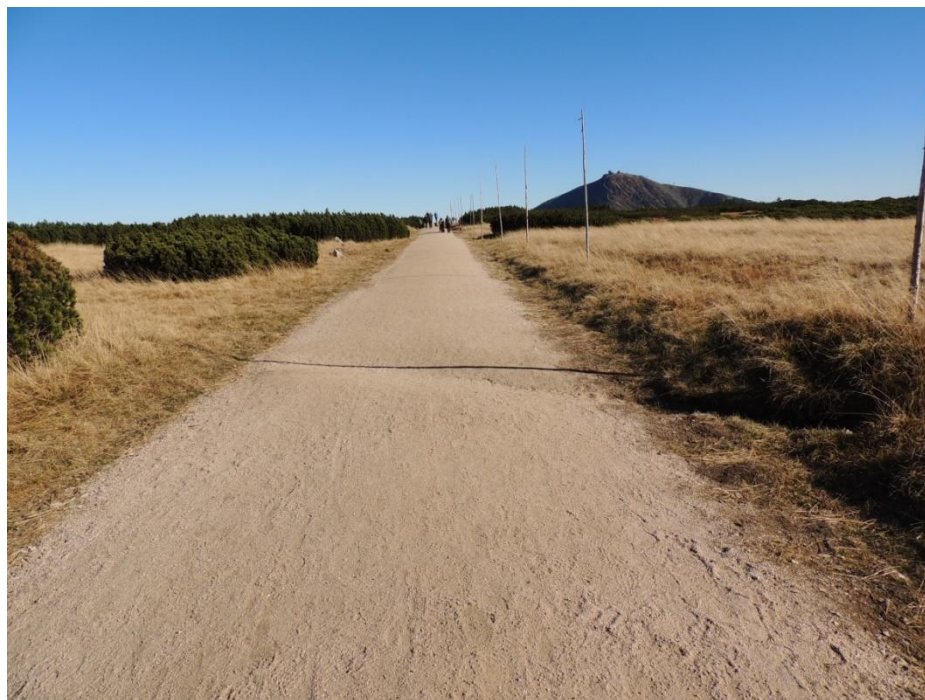
Obr. 18: Zemní chodník se svodnicí v 1. úseku turistického chodníku Luční bouda – Obří bouda.
