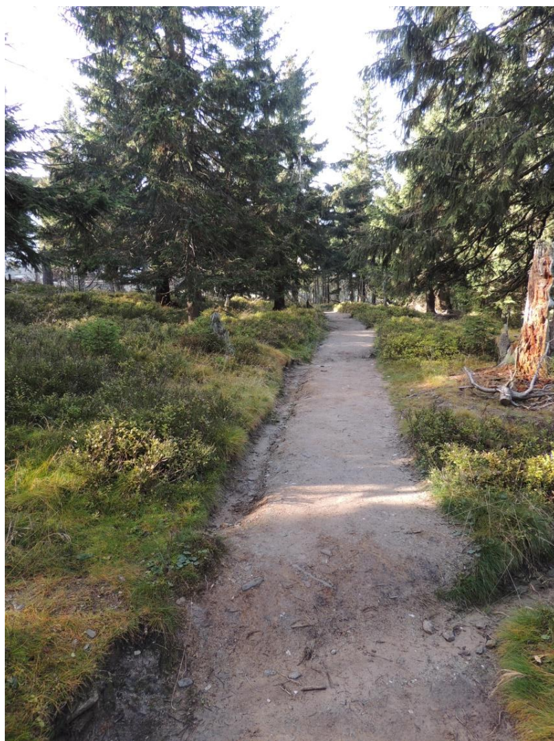
Obr. 8: Podélné a příčné odvodnění zemního chodníku Pod Petrovou boudou.
