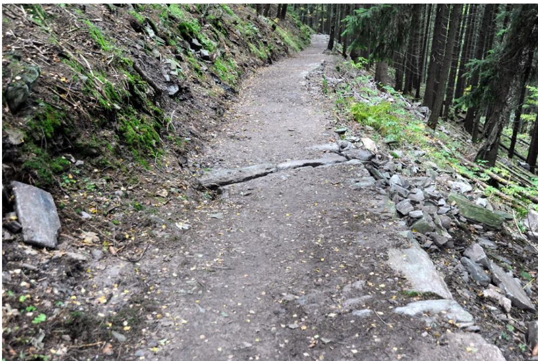
Obr. 10: Dlážděný úsek Kubátovy cesty, s příčným odvodněním a vrchní vrstvou jemného materiálu. Dostupné z: < http://www.krnap.cz/rekonstrukce-turistickych-chodniku-ve-vychodnich-krkonosich/ >
