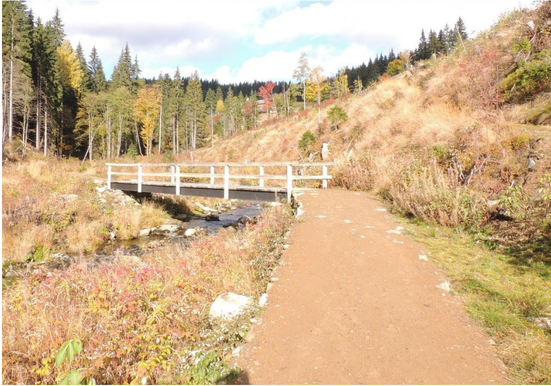
Obr. 23: Konec rekonstruovaného úseku chodníku Pec pod Sněžkou – Zelený důl se 14 metrů dlouhým mostem přes Zelený potok.
