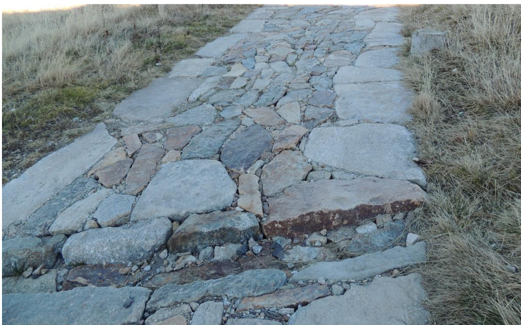
Obr. 13: Začátek štetovaného turistického chodníku u Luční boudy s kamennou svodnicí.
