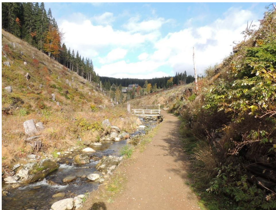
Obr. 22: Štětovaný úsek turistického chodníku Pec pod Sněžkou – Zelený důl s opěrnou zdí a dřevěným mostem.
