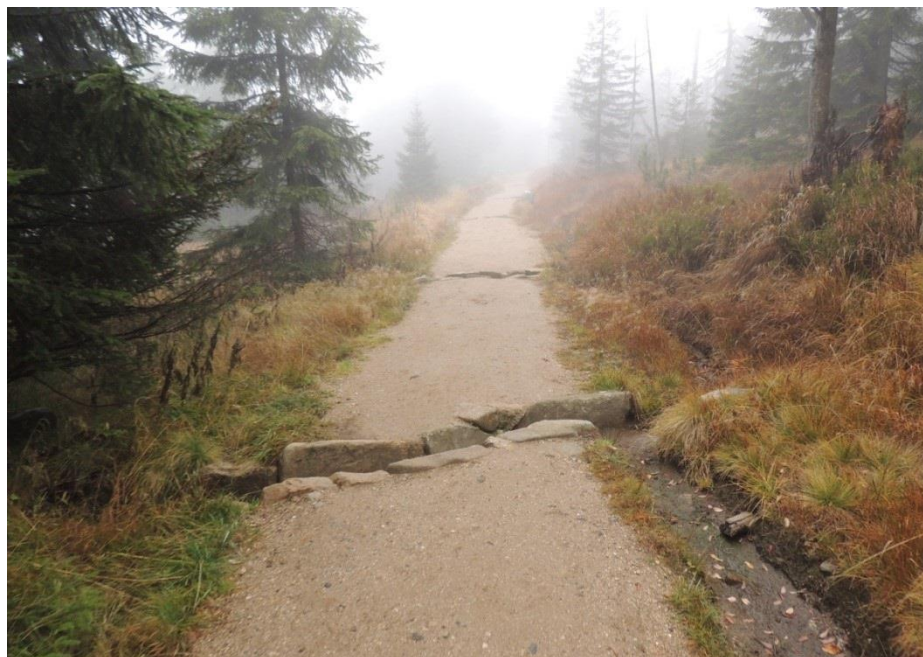
Obr. 27: Zemní chodník pod Petrovou boudou zakalený prachem se svodnicemi vyskládaných z kamenů.
