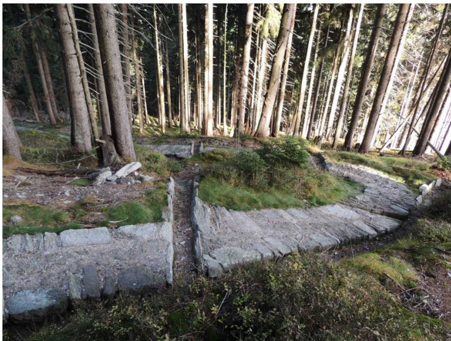
Obr. 33: Štětovaný chodník Zvonková – Pardubické B. – Č. Hora s kamennými svodnicemi.
