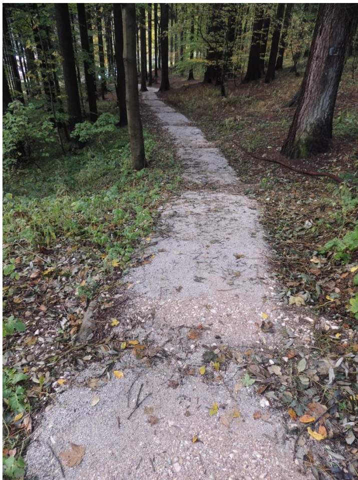
Obr. 35: Zemní chodník pod horskou službou se zemními svodnicemi.
