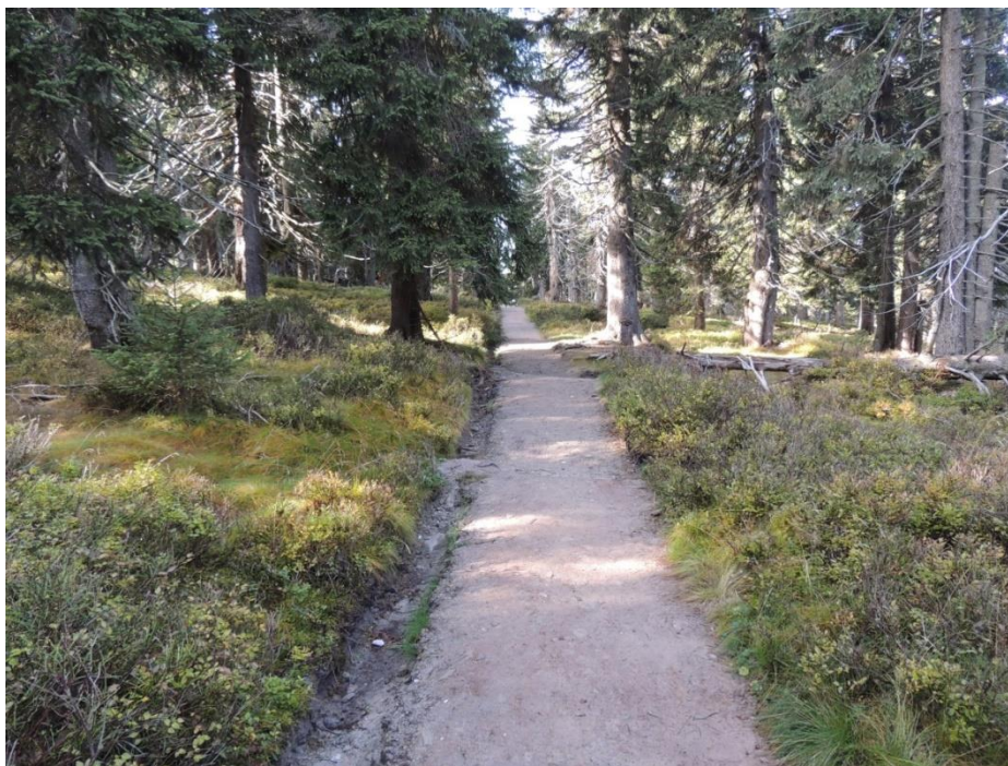
Obr. 31: Zemní chodník Zvonková – Pardubické B. – Č. Hora zakalený prachem s podélným odvodňovacím příkopem.
