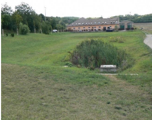
4.1-4 Suchý poldr v obci Moravany [7]
