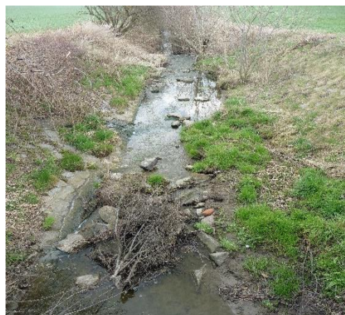
4.1-11 Sedimentace v korytě u ČOV [7]
