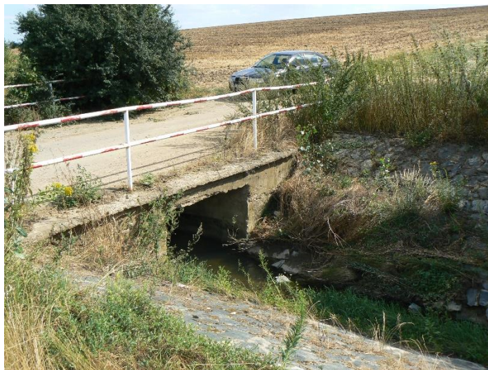
8.1-34 Betonový most nad místem odběru [4]
