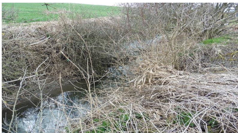
4.2-25 Koryto potoka před průmyslovou oblastí[7]
