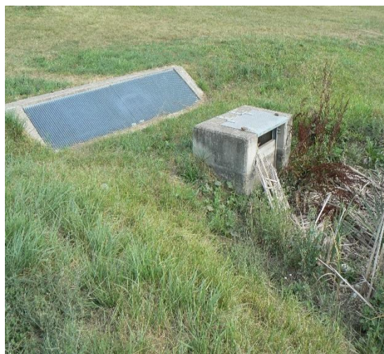
4.1-5 Suchý poldr v obci Moravany [7]
