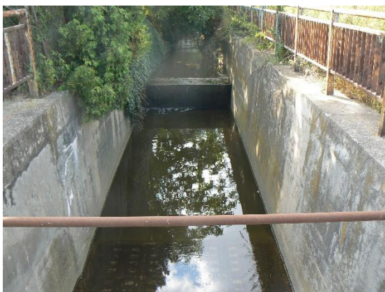
4.1-20 Obdélníkové betonové koryto[7]
