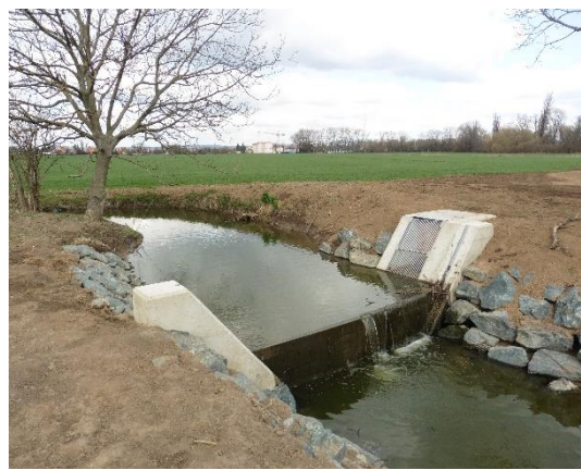
4.2-29 Vtok do vodní nádrže[7]
