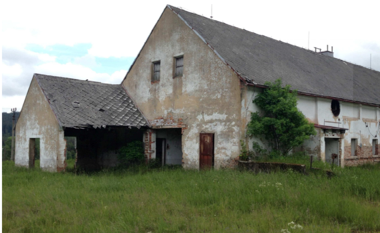
Obrázek 9: Původní stav objektu Zdroj: Architektonická studie
