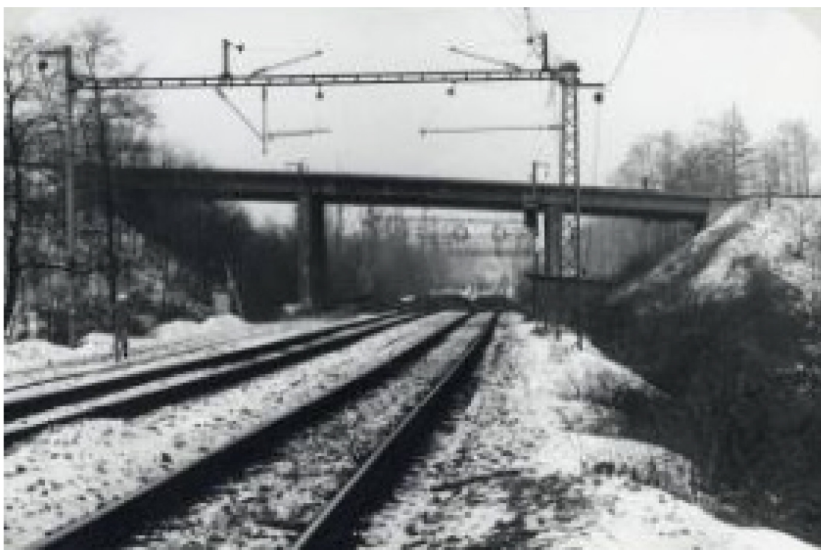
Obrázek 12: Historický pohled na kolejový most nad tratí Košice – Bohumín ve Stonavě (Lukačík, 1977)
