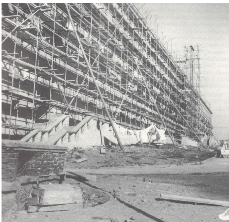
Obrázek 48: Historický pohled na výstavbu Beethovenovy ulice v Havířově (Benatzky a kol., 1995)
