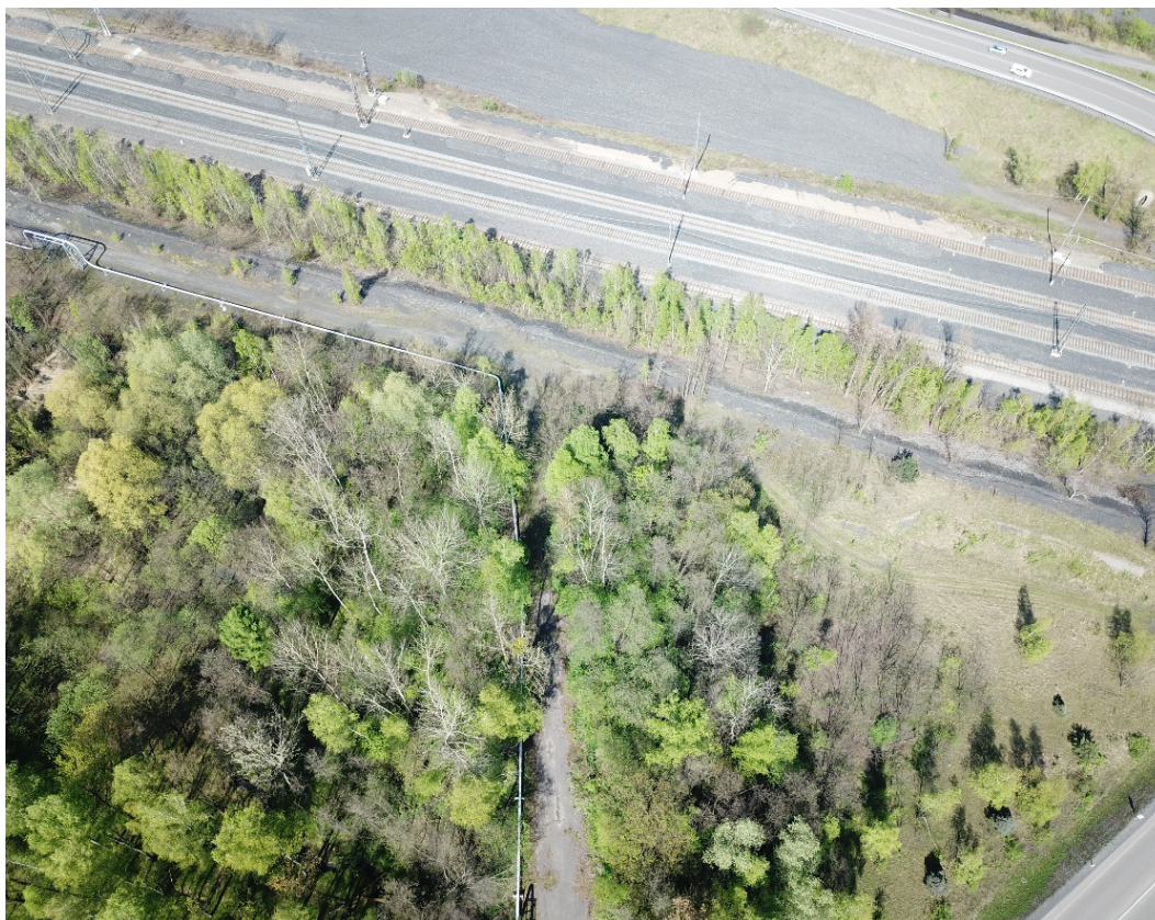
Obrázek 13: Letecký záběr z dronu na místo, kde stával odstřelený kolejový most nad tratí Košice – Bohumín ve Stonavě (Niemiec, 2023)
