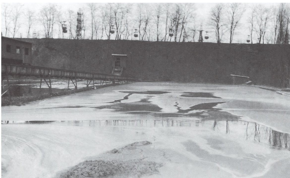
Obrázek 38: Historický způsob naplavování uhelných kalů (Kratochvíl a kol., 2002)
