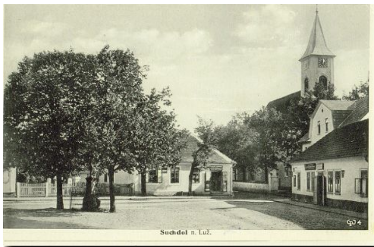
obr. č. 2 – historický pohled Suchdola nad Lužnicí
