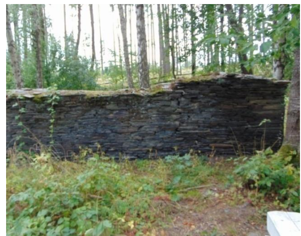
Foto 5: Zakládka odpadní suroviny (foto A. Mokrá).
