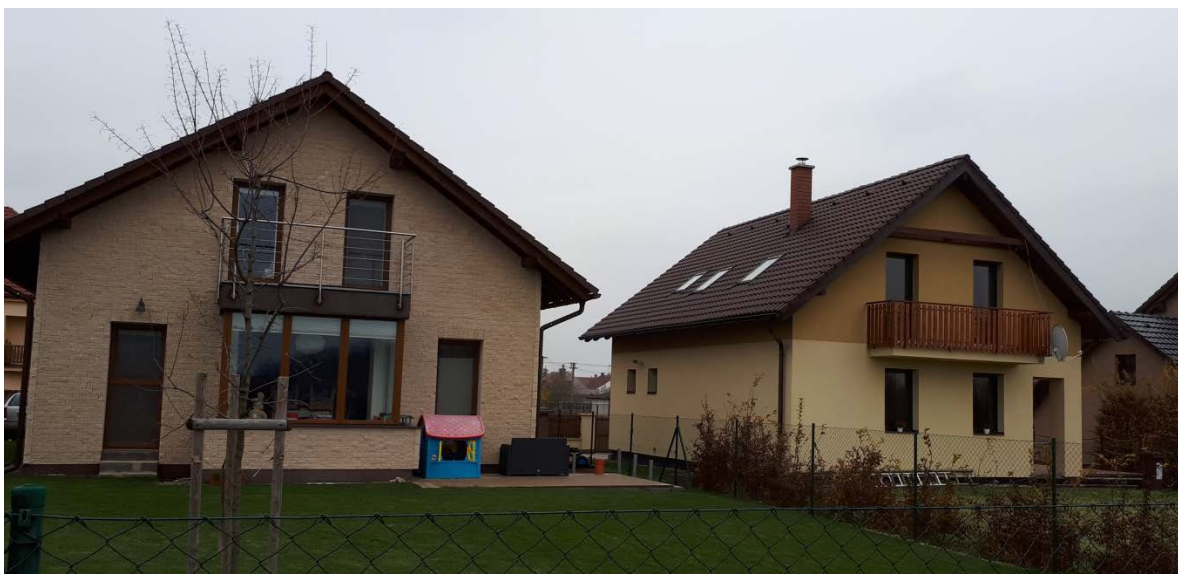
Obr. 6.6: Pohled na sousední dům ze severní strany
