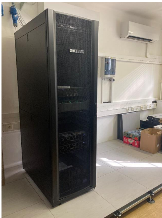
obrázek č. 23 – Instalace DELL racku do serverovny, zdroj: vlastní zpracování
