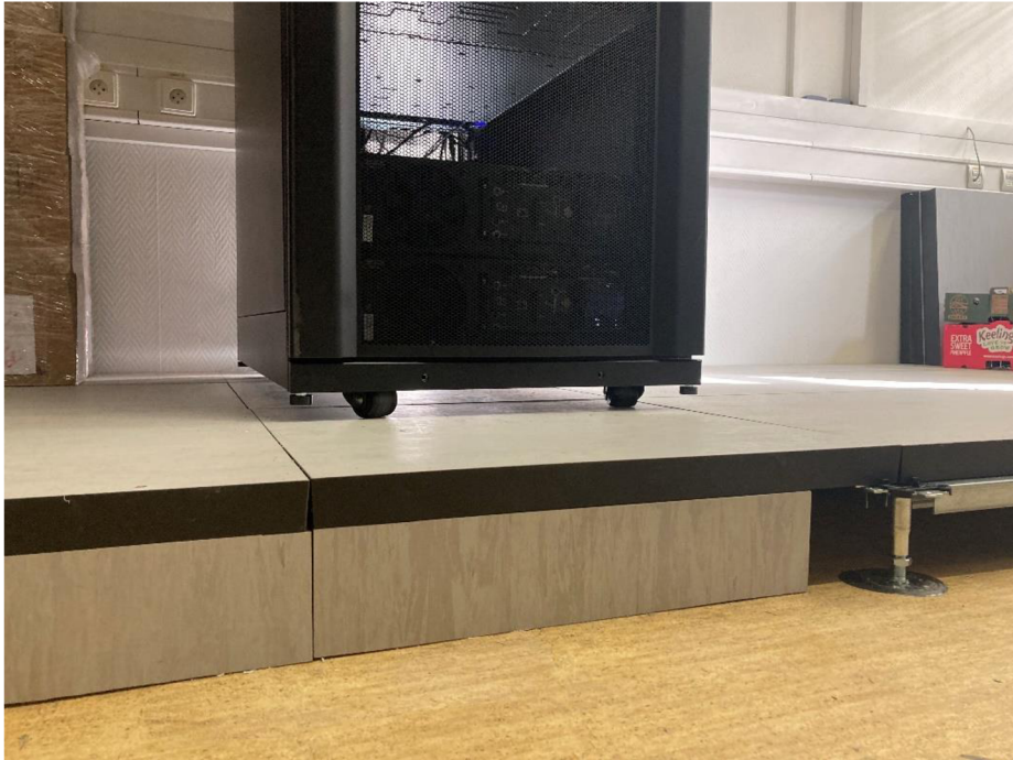
obrázek č. 24 – Ukázka speciální vyvýšené podlahy, zdroj: vlastní zpracování
