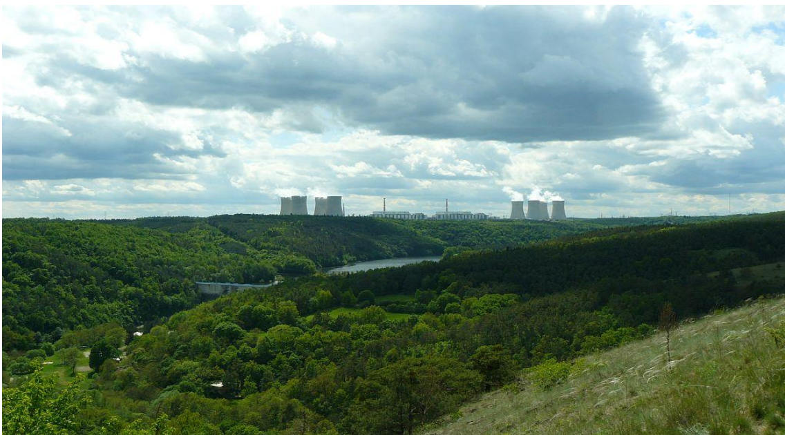
Obr. 9: Jaderná elektrárna Dukovany a vodní nádrž Mohelno (zdroj vlastní)
