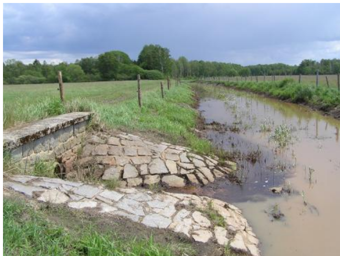
Obrázek č. 34: V JZ části území jsou dosud funkční prvky odvodňovací soustavy, které jsou zaústěny do Blatské stoky. Tmavě zbarvená voda představuje povrchový odtok vody z rašeliniště, zdroj: Šiška (2005).
