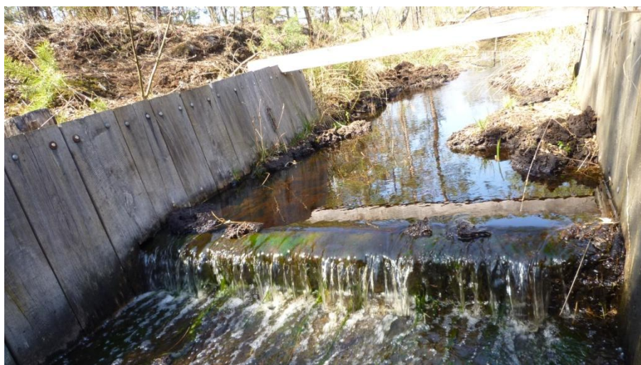
Obrázek č. 23: Přehrazení jednoho ze dvou příkopů, do kterého je soustředěn odtok vody z rašeliniště (umístění na mapě viz příloha č. 4, bod 2), zdroj: foto autor.
