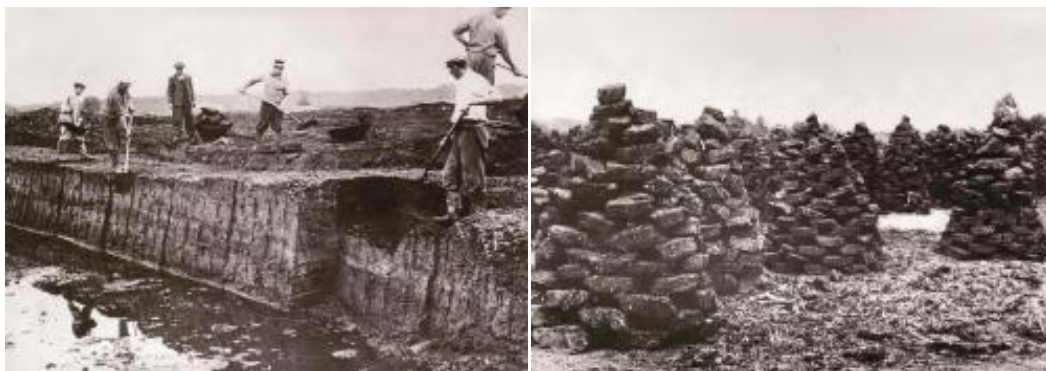
Obrázek č. 14 a č. 15: Těžba rašeliny – borkování, sušení borek v kapliče, zdroj: http://www.raselina.cz/historie , dostupný dne 13. 4. 2013.
