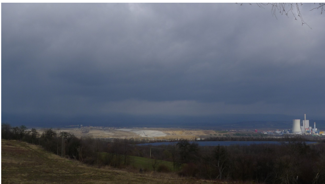
foto 5 – Doly Bílina a Elektrárna Ledvice z pohledu severně od PLZMV z úpatí vrchu Kaňkov (Votava 2016)
