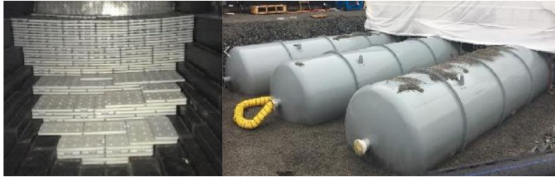
Obrázek 22 NMBU PCM zásobník chladu, vnitřní pohled na naskládané desky s PCM (vlevo) a vnější pohled na nádrže, obsahující desky (vpravo) [22]
