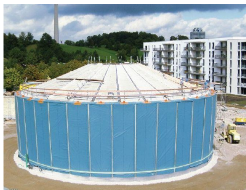
Obrázek 4 Vodní nádrž v Mnichově při výstavbě [8]
