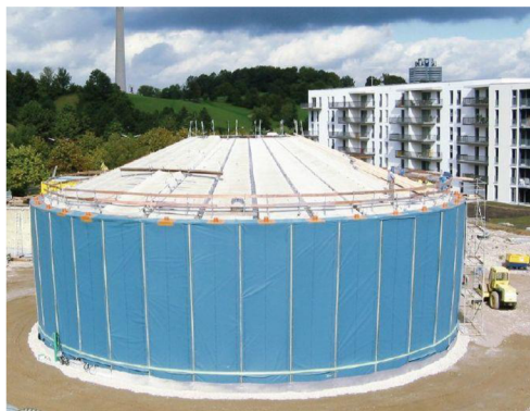
Obrázek 4 Vodní nádrž v Mnichově při výstavbě [8]
