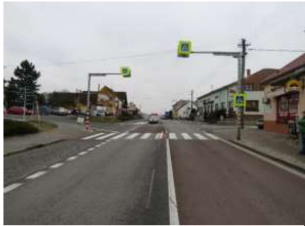
Obr. č. 9 Směr Brno (51)
