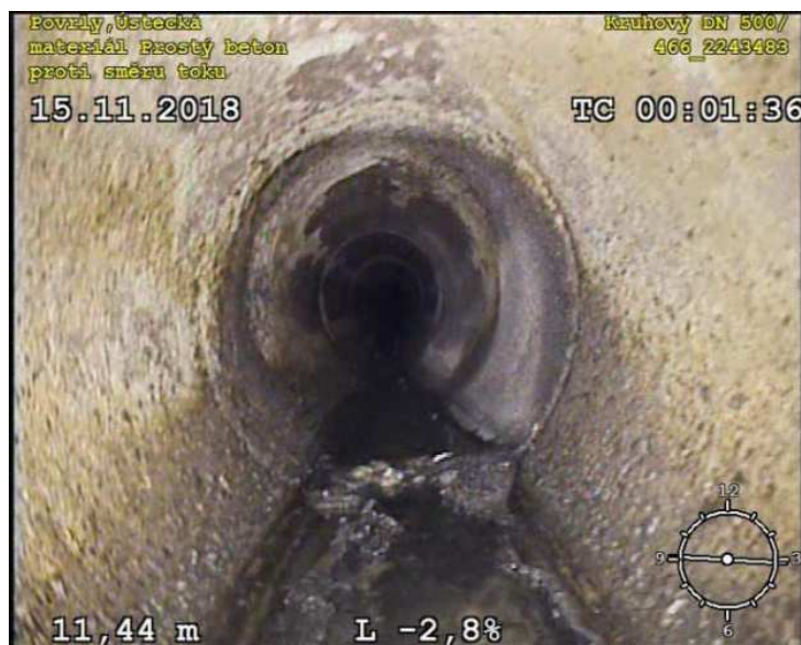
Obr. 33 - Uplývající kompaktní materiál ve dně
