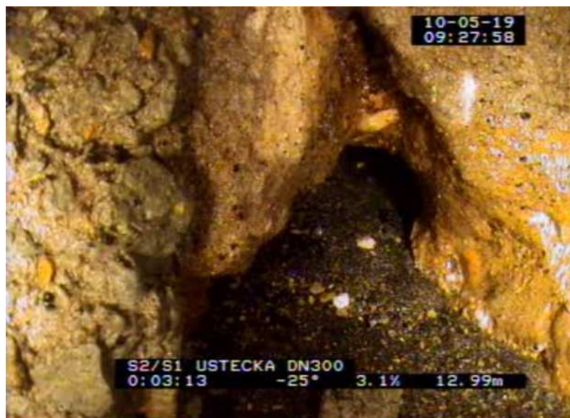
Obr. 15 - Viditelná zemina ve spoji
