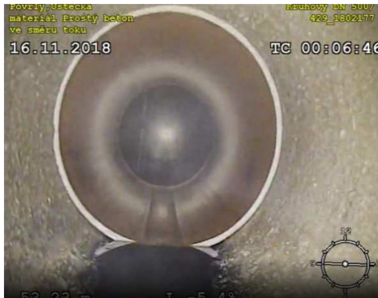
Obr. 38 - Změna materiálu potrubí na PVC
