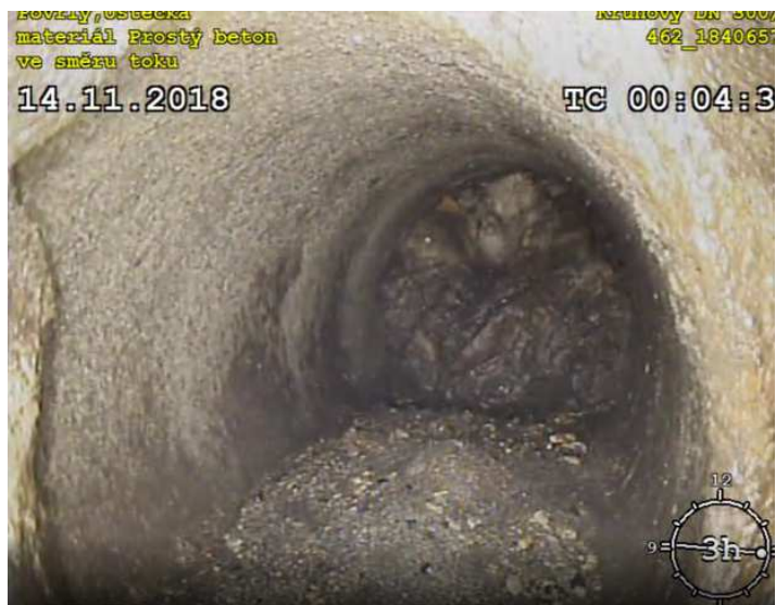
Obr. 20 - Zavalená přípojka
