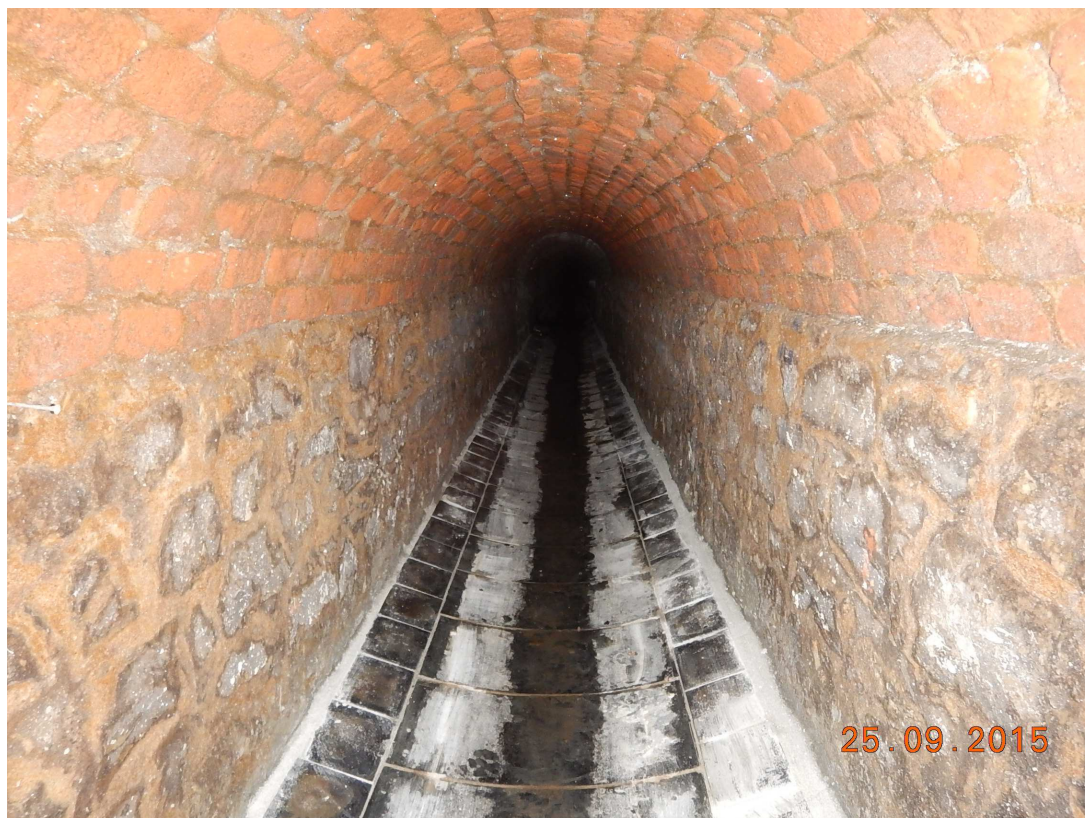
Obr. 9 - Monolitická stoka s vystlaným dnem z taveného čediče
