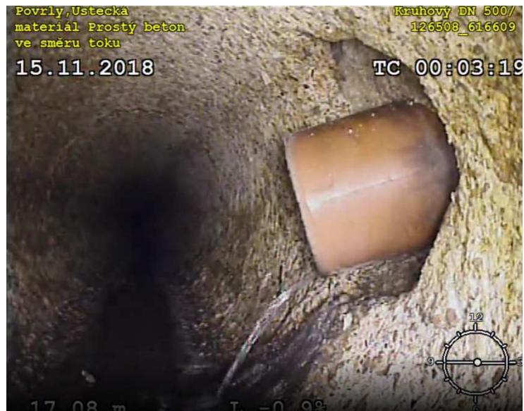
Obr. 30 - Přesazená přípojka
