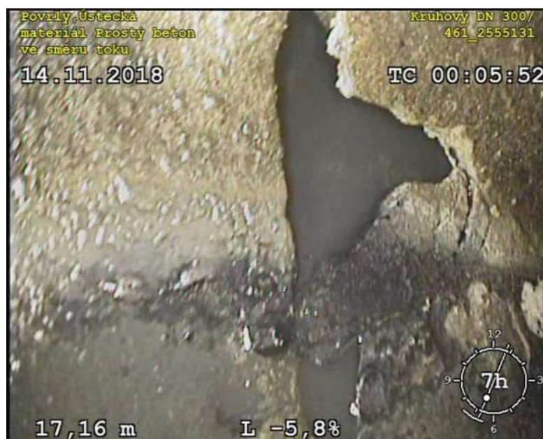
Obr. 17 - Kaverna ve spoji
