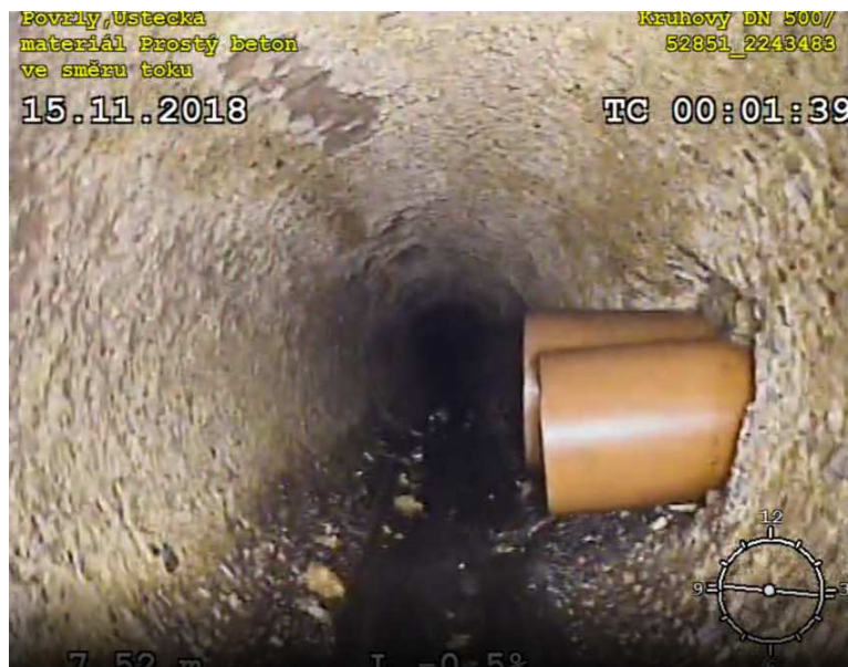
Obr. 34 - Přesazené přípojky
