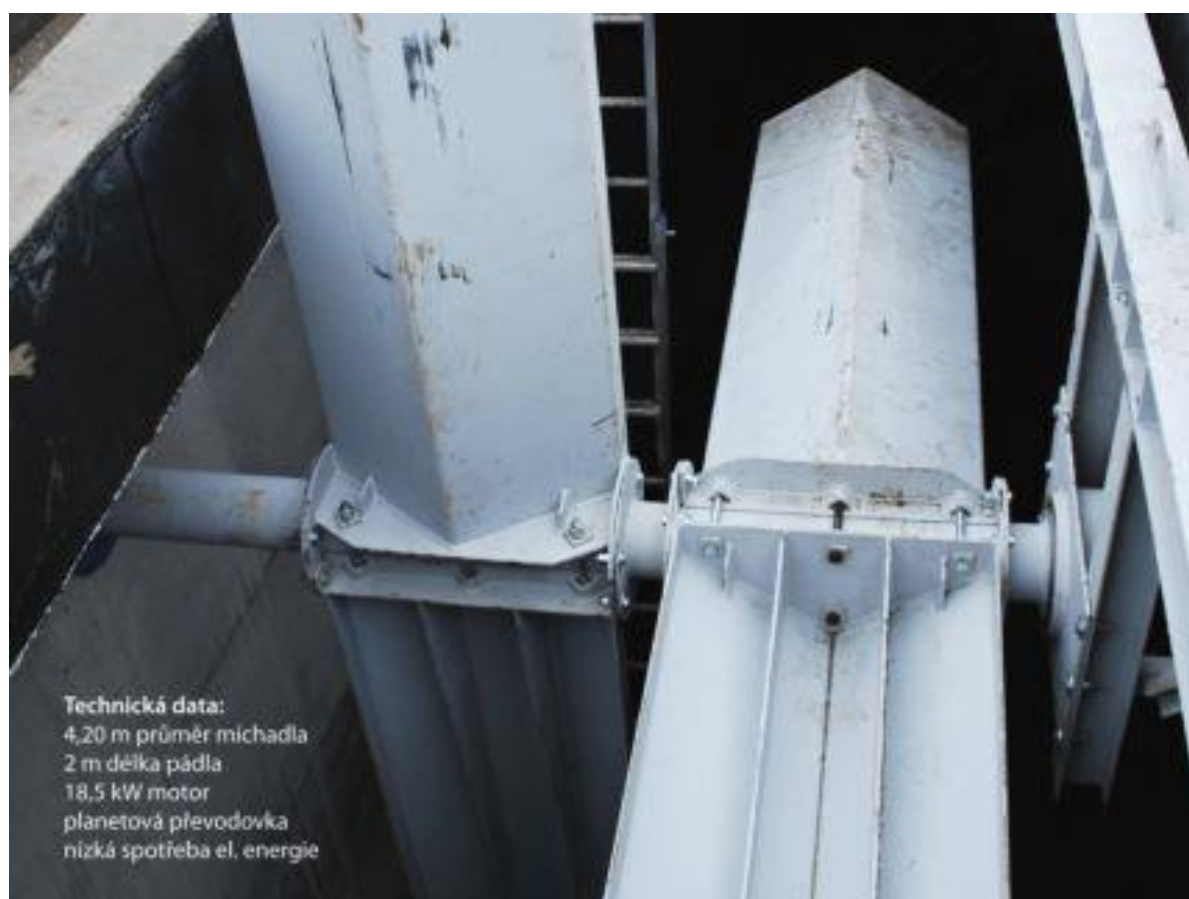
Obr. 6 Horizontální pádlové míchadlo
