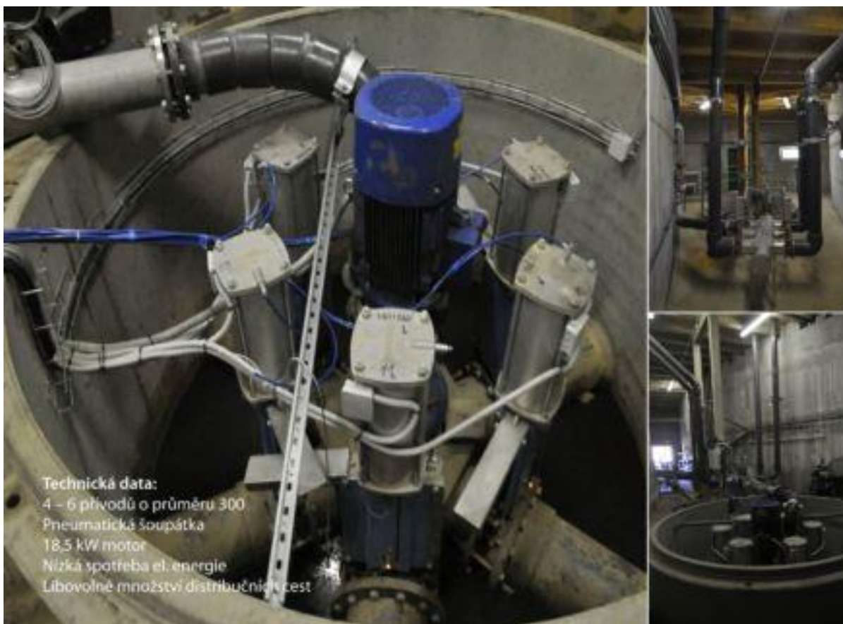
Obr. 9 Centrální čerpadlo s 6 přívody
