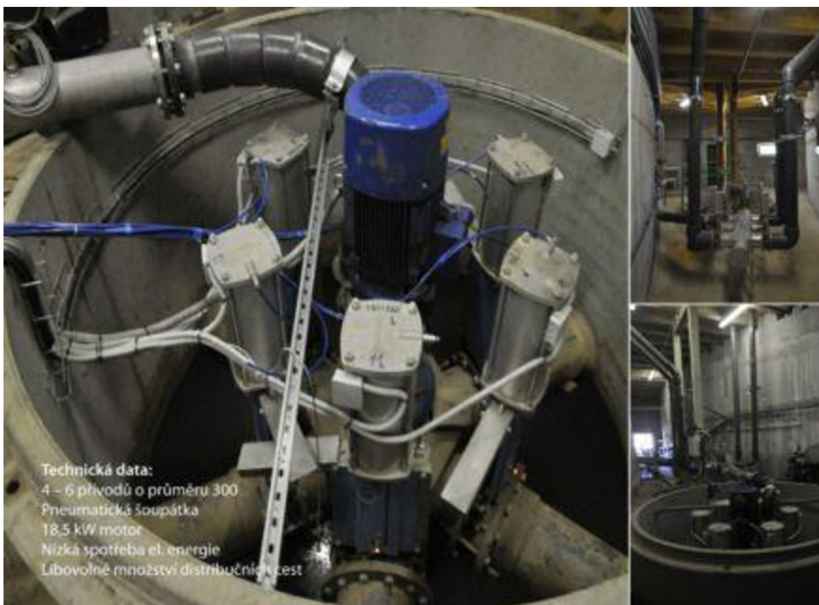
Obr. 9 Centrální čerpadlo s 6 přívody
