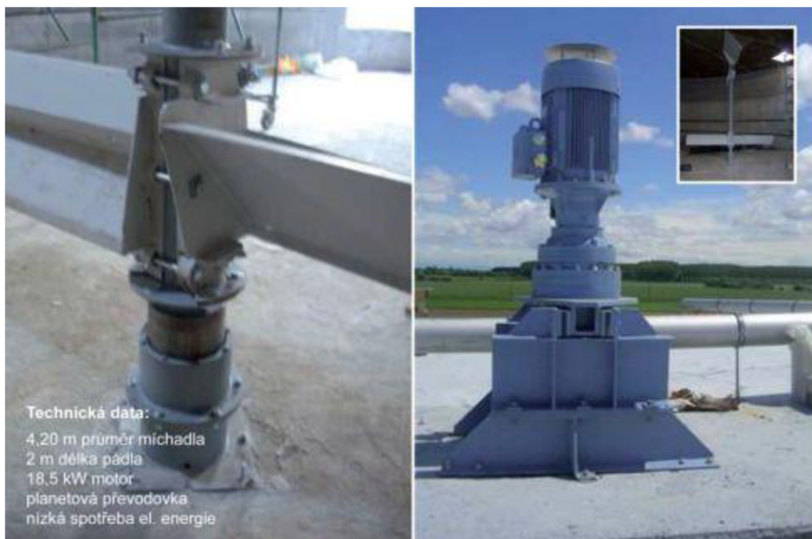
Obr. 7 Vertikální pádlové míchadlo
