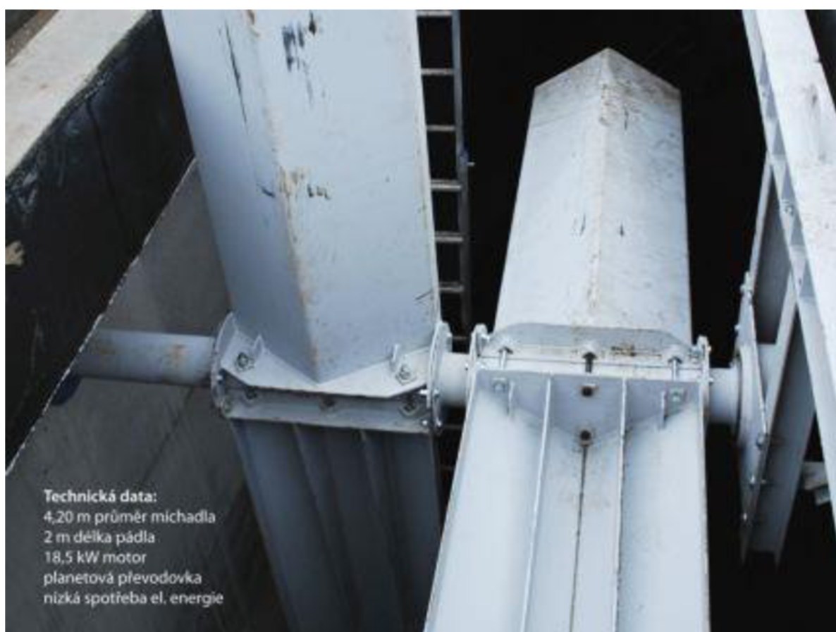
Obr. 6 Horizontální pádlové míchadlo
