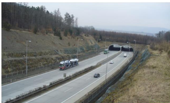
Obr. 31: Komunikační průkop a ekodukt u Dolního Újezdu
