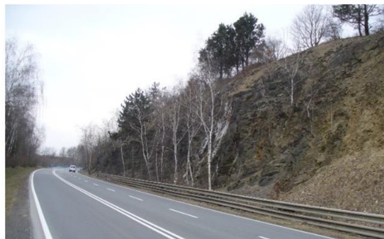
Obr. 32: Silniční zářez u Skoků
