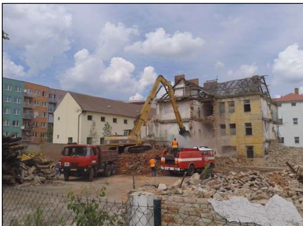
Obr. 68: Druhá etapa demolice II, 2016 (zdroj: Benešovský deník)
