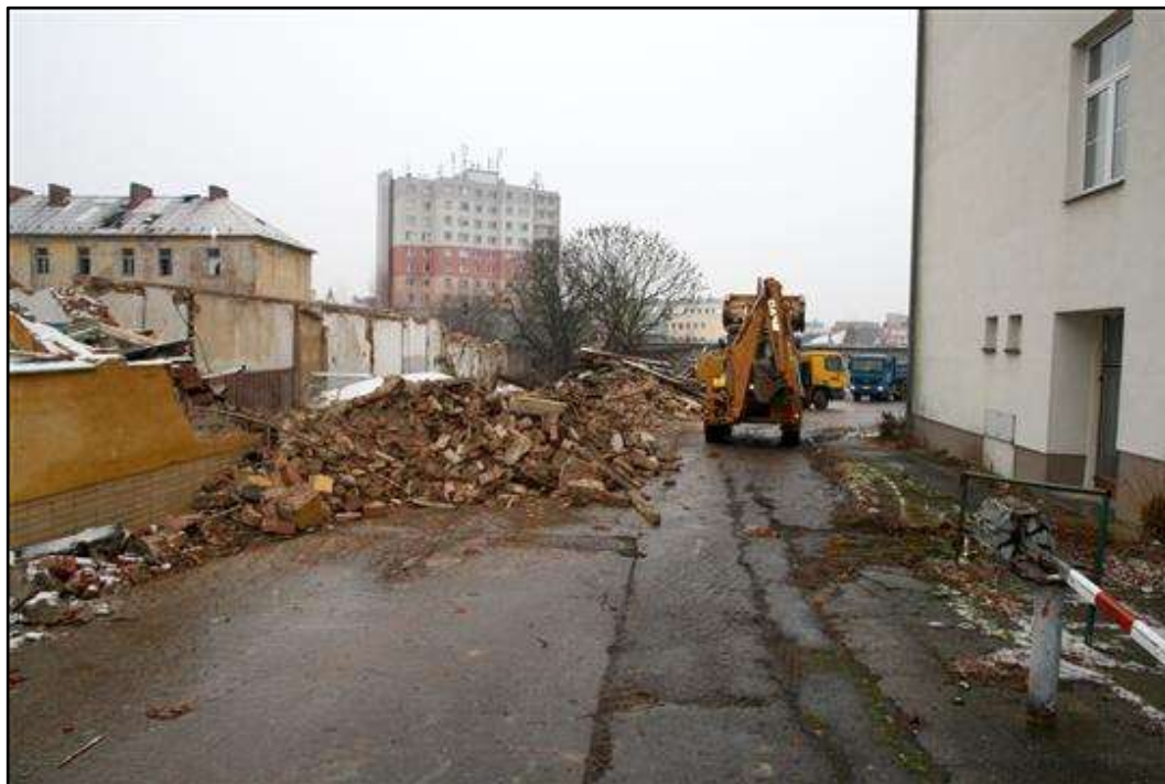
Obr. 38: Demolice první etapa – I (zdroj: Radniční listy)
