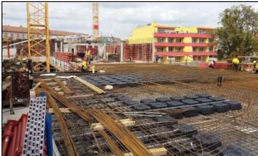
Obr. 62: Green park – realizace II, 2016 (zdroj: zapa.cz)
