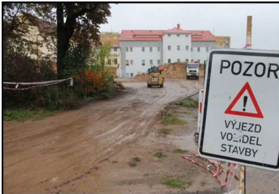
Obr. 67: Druhá etapa demolice I, 2016 (zdroj: Benešovský deník)
