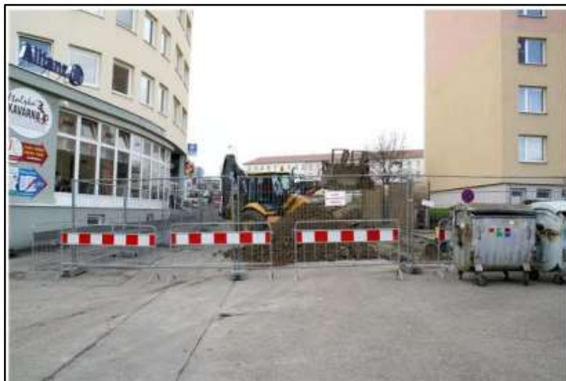
Obr. 45: Realizace stavby komunikace Karla Nového II, 2012 (zdroj: Radniční listy)
