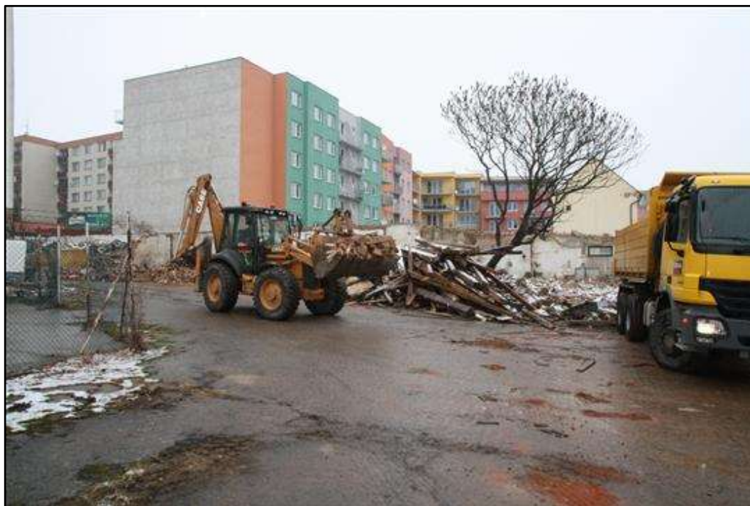
Obr. 39: Demolice první etapa – II (zdroj: Radniční listy)
