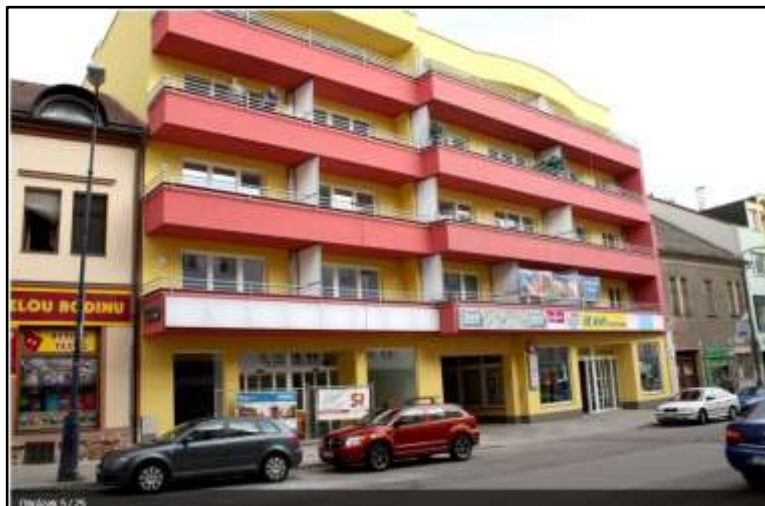
Obr. 54: Integrovaný dům – pohled z ulice Karla Nového, 2018 (zdroj: mapy.cz)
