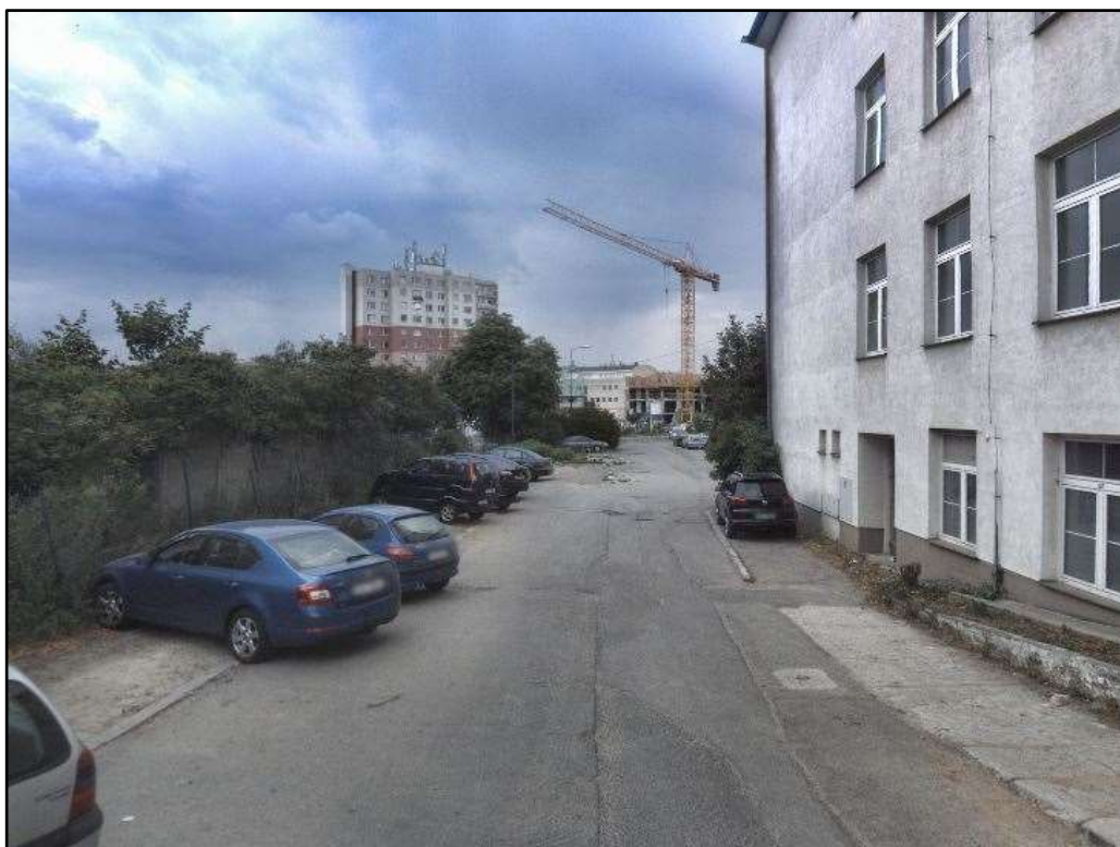
Obr. 37: Po demolicí, pohled z ulice Dukelská (zdroj: mapy.cz)
