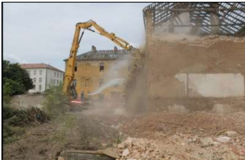
Obr. 70: Druhá etapa demolice IV, 2016 (zdroj: Benešovský deník)
