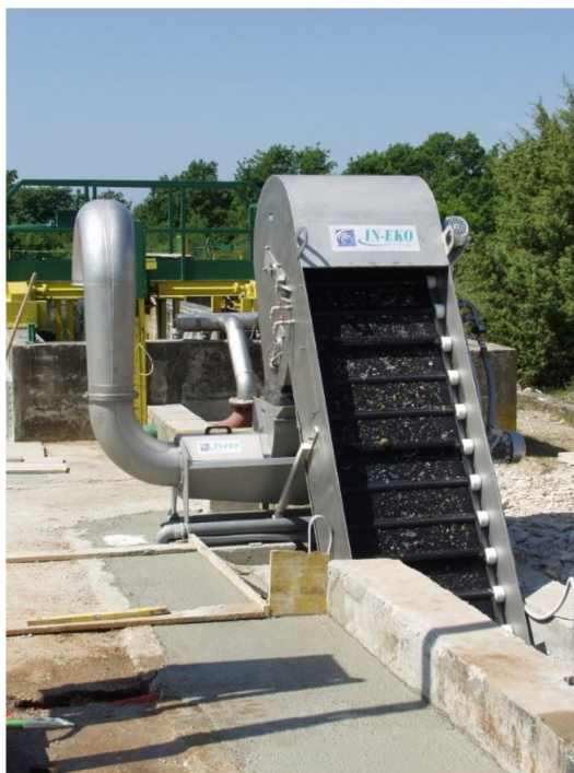
Obr. 4 Samočisticí česle [57]
