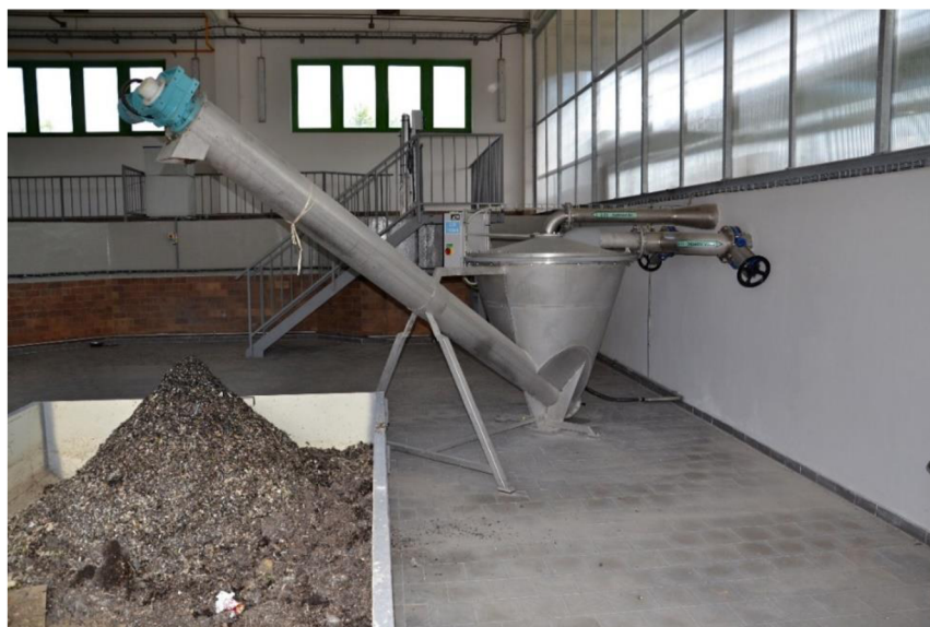
Obr. 5 Vertikální lapák písku [57]
