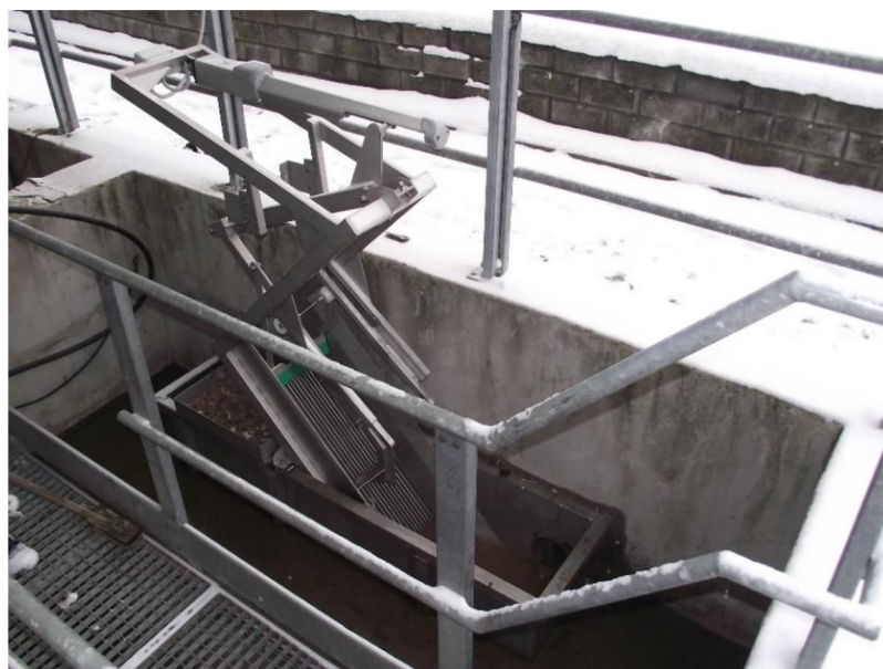
Obr. 3 Česle strojně stírané [57]
