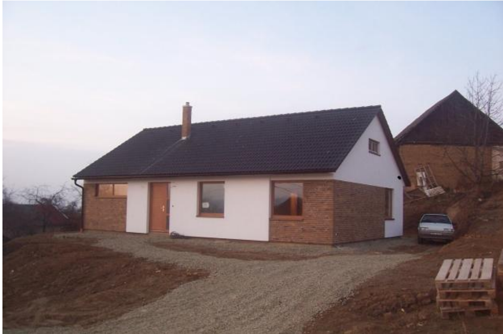
Obr. č. 6 - Skutečný stav RD, pohled jihovýchodní 120
