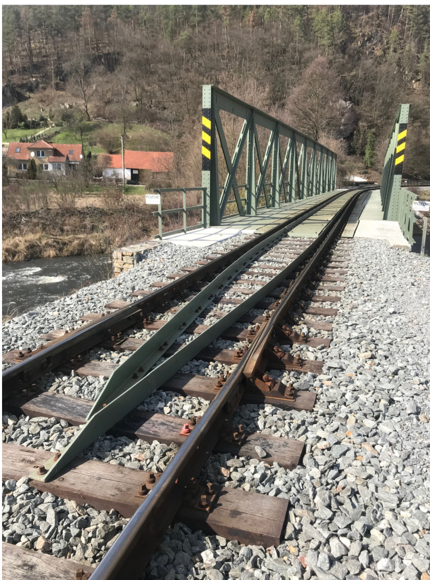
Kolejové malé dilatační zařízení, které bude odstraněno
