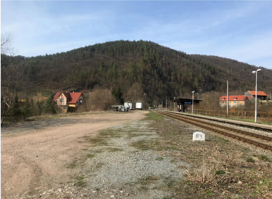
Prostor pro stavbu nástupiště a výhybku ve stanici Borač
