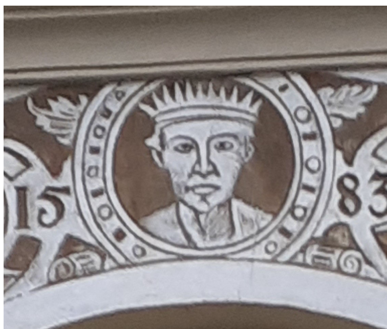
Obr. 8d medailon č.4, David/Šalamoun, dům čp. 265, průčelí
