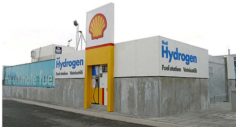
Obr. 48: Veřejná čerpací stanice v Reykjavíku (otevřena v roce 2003)
