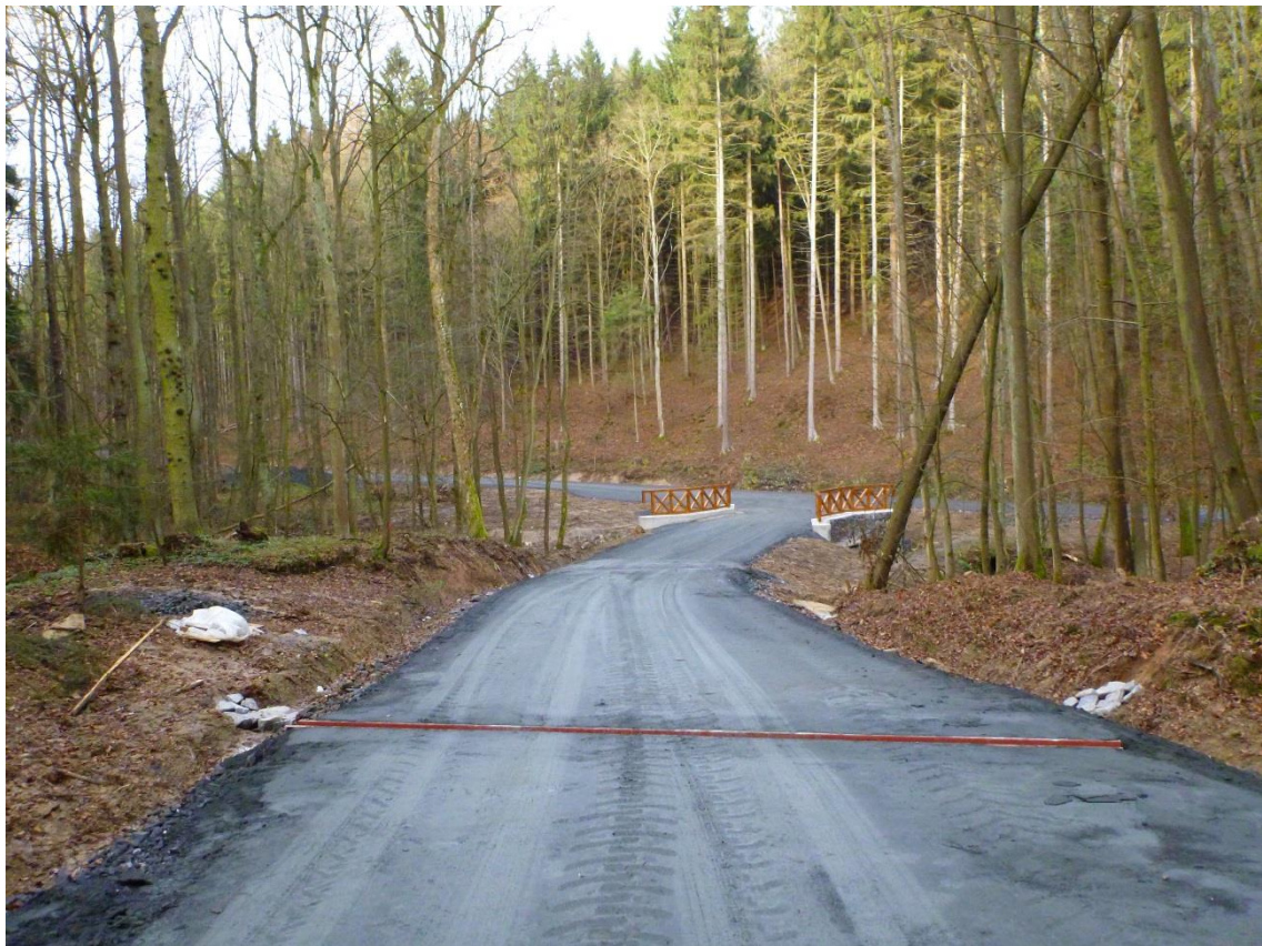
Obr. 15 Lesní cesta Údolní II B.
