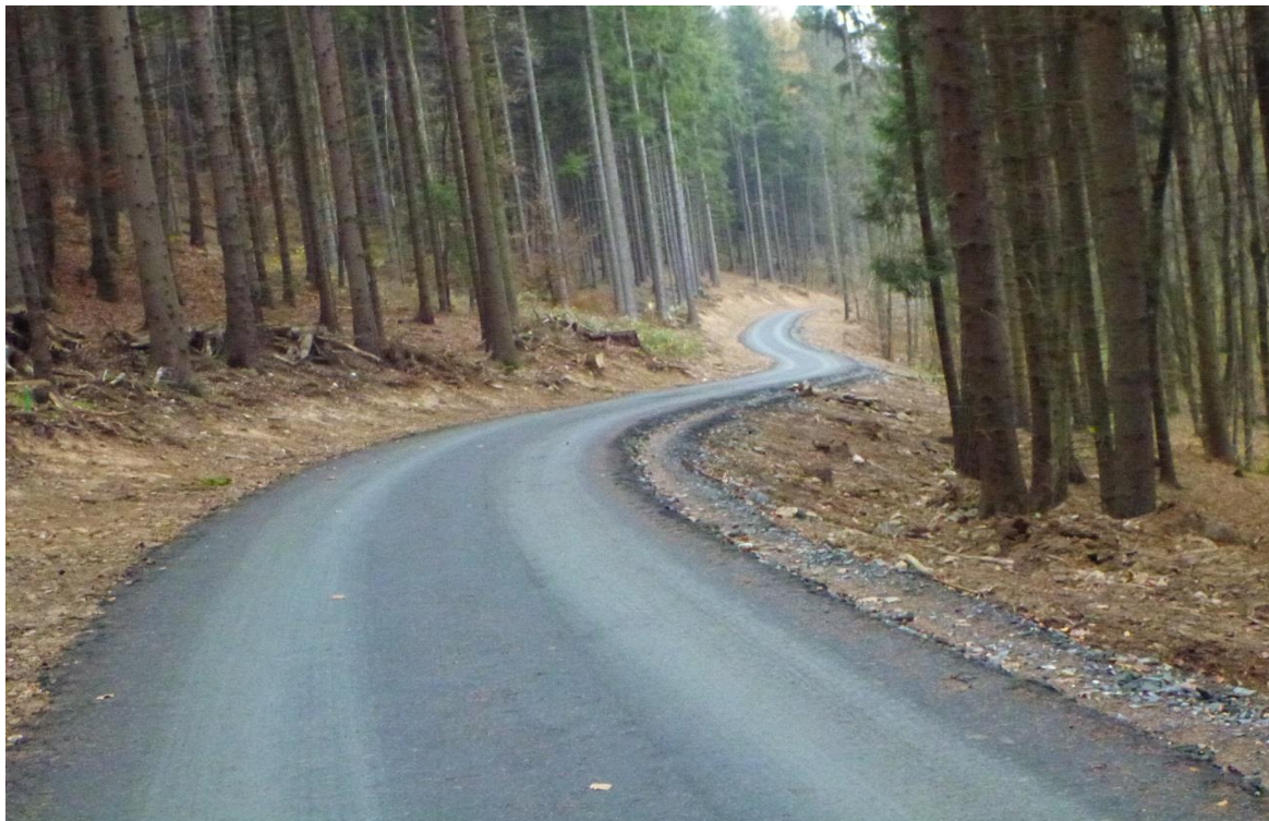
Obr. 14 Lesní cesta Údolní II. B
