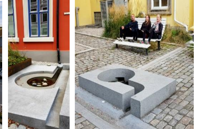
Obr. 36: Odvodňovací žlaby vedoucí vodu z okapů.
