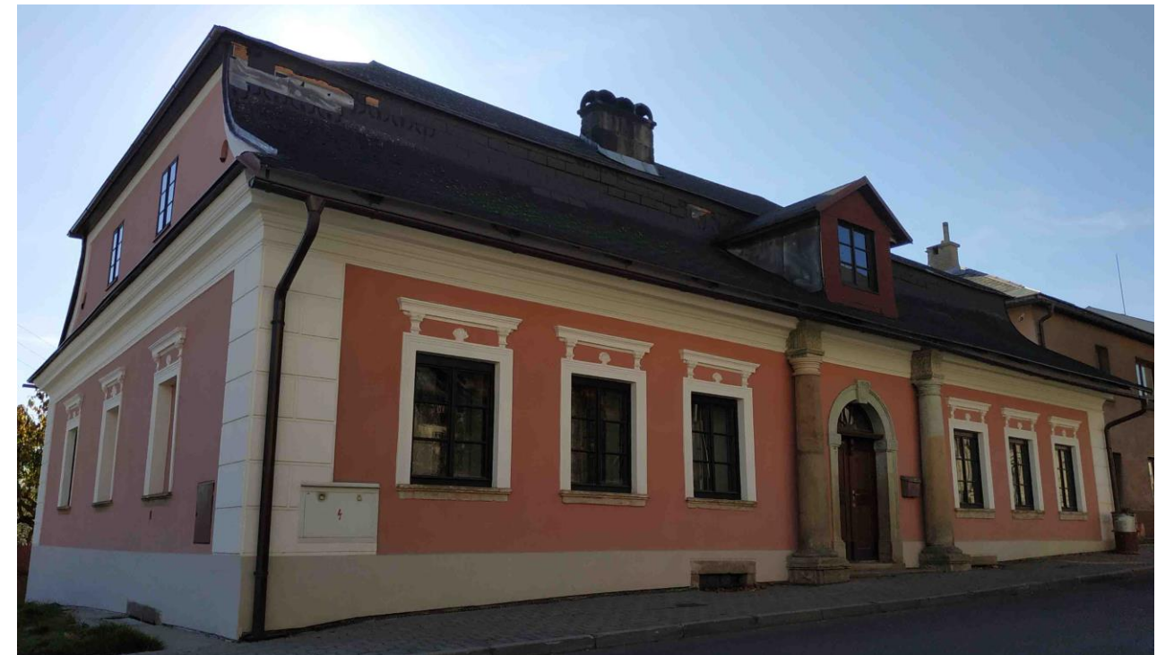
Obr. 122: Řešení kamenného tělesa dýmníkového komína s třemi průduchy na domu čp. 67 - vedle tržiště na náměstí
