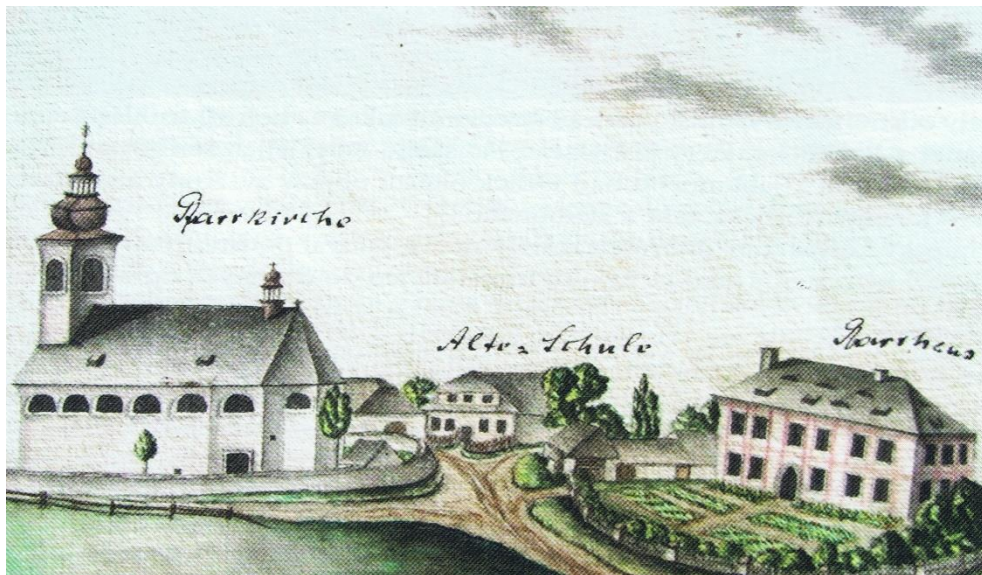
Obr. 74: Veduta budov ze sedmdesátých let 18. století s barokní barevností fasád
