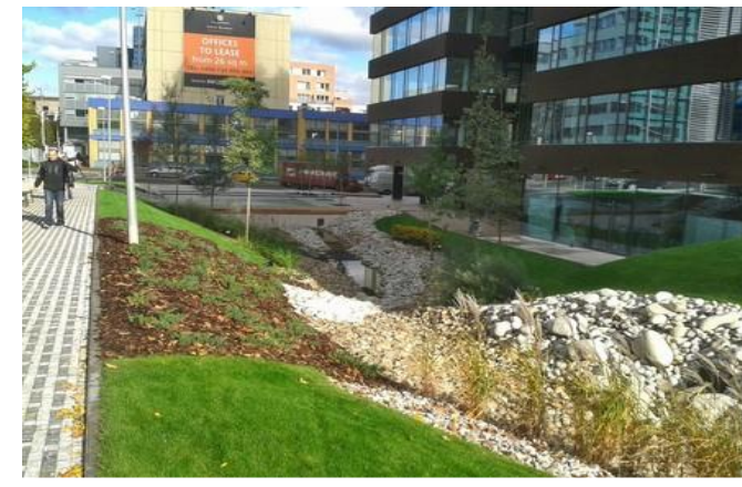
Obr. 42: Retenční nádrž budovy Delta v Praze, jež má podobu říční delty.
