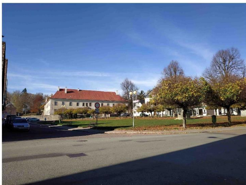
Obr. 133: Pohled z rohu domu na zámek Rokytnice
