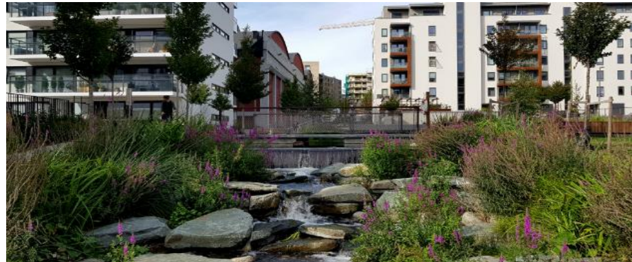
Obr. 37-39: Ensjøbyen je megaprojekt čtvrti v Oslu, který je v rámci zeleno-modré infrastruktury téměř světový unikát. Různorodé dešťové prvky jsou tu vzájemně propojeny. Vodní plocha prostředního obrázku zachytává dešťovou vodu z místních střech a přebytek vody díky gravitaci stéká dál do městského potoka nové čtvrti, zobrazeného na posledním obrázku. Potok dešťovou vodu zpomaluje, pročišťuje a propojuje prvky budované infrastruktury.
