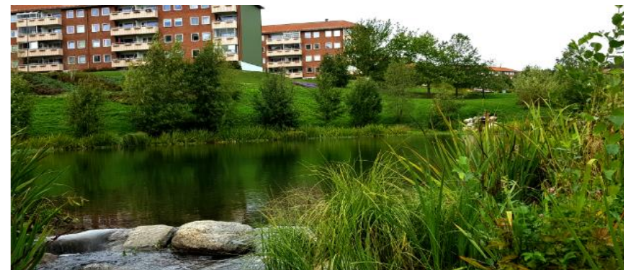
Obr. 37-39: Ensjøbyen je megaprojekt čtvrti v Oslu, který je v rámci zeleno-modré infrastruktury téměř světový unikát. Různorodé dešťové prvky jsou tu vzájemně propojeny. Vodní plocha prostředního obrázku zachytává dešťovou vodu z místních střech a přebytek vody díky gravitaci stéká dál do městského potoka nové čtvrti, zobrazeného na posledním obrázku. Potok dešťovou vodu zpomaluje, pročišťuje a propojuje prvky budované infrastruktury.
