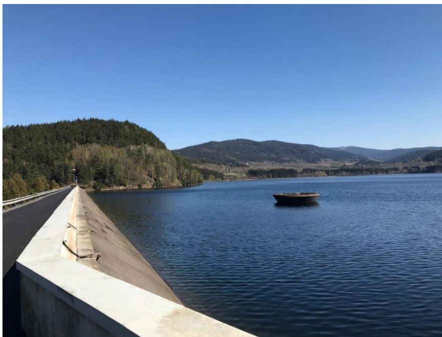
Obrázek č. 4 Hráz vodní nádrže
