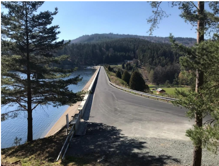
Obrázek č. 2 Hráz vodní nádrže
