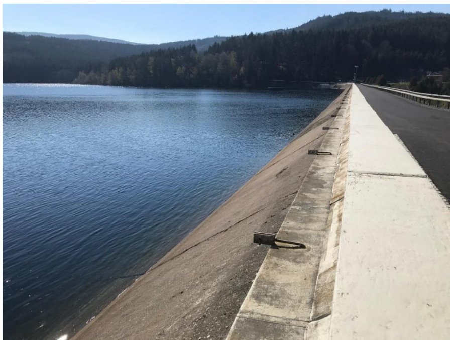
Obrázek č. 3 Hráz vodní nádrže
