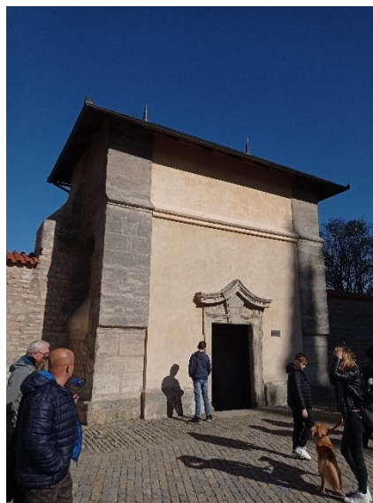
Obrázek č. 55: Dnešní vstup do kaple Božího těla
