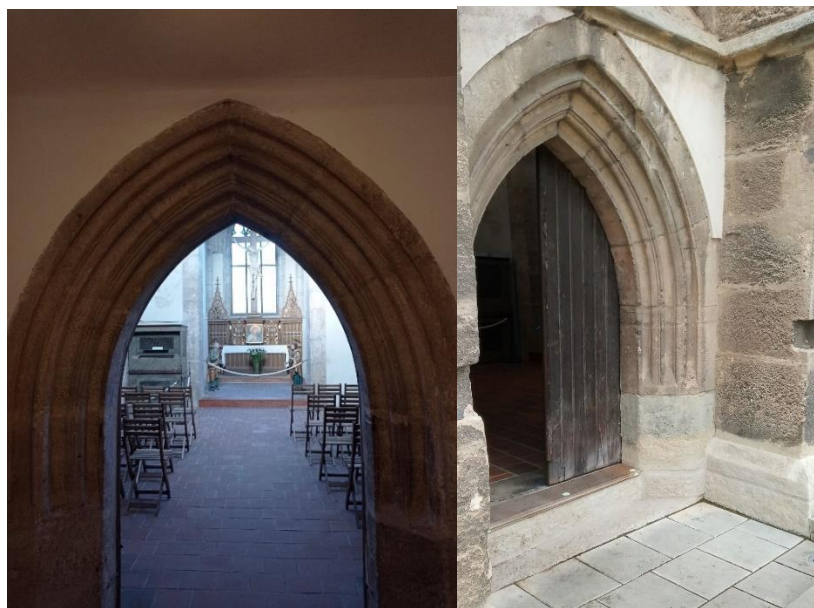
Obrázek č. 38: Portál do horní kaple z předsíně
