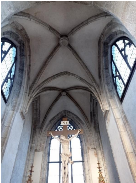
Obrázek č. 36: Klenba v presbytáři horní kaple
