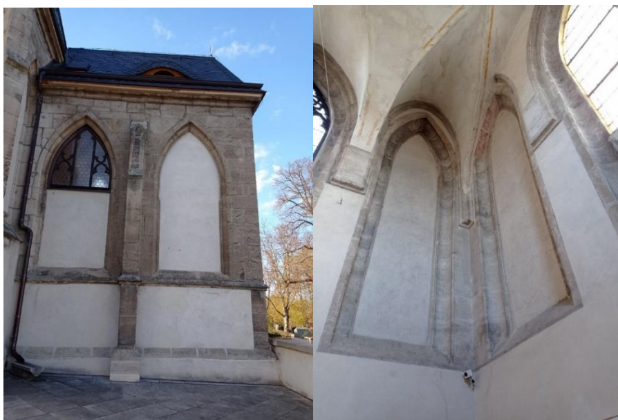
Obrázek č. 40: Zazděná okna v horní kapli (pohled z terasy)
