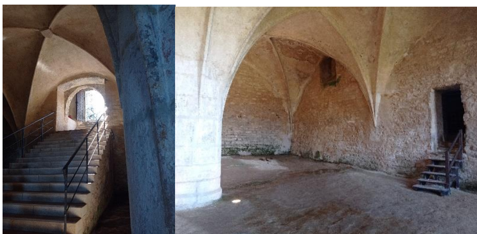
Obrázek č. 59: Schodiště
