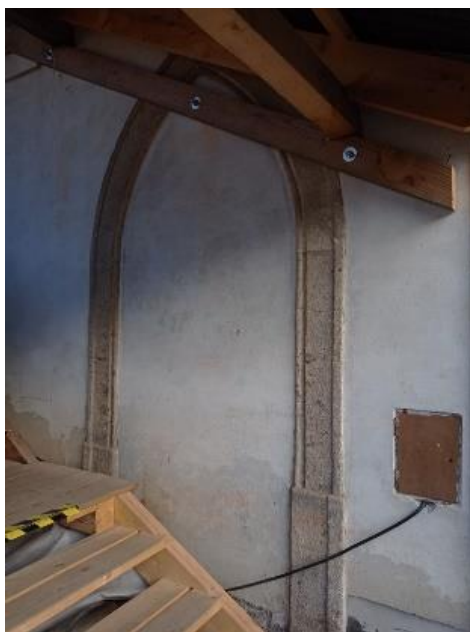
Obrázek č. 42: Zazděné okno v předsíni
