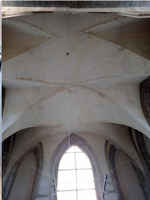
Obrázek č. 37: Klenba v lodi horní kaple
