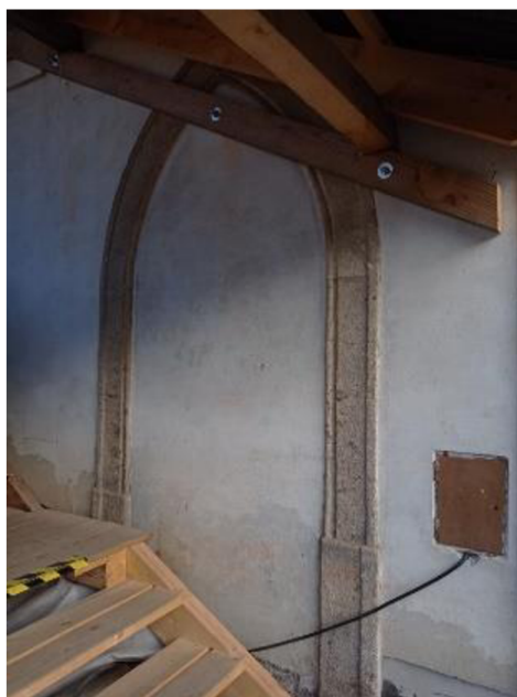
Obrázek č. 42: Zazděné okno v předsíni
