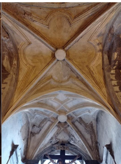
Obrázek č. 24: Klenba v presbytáři
