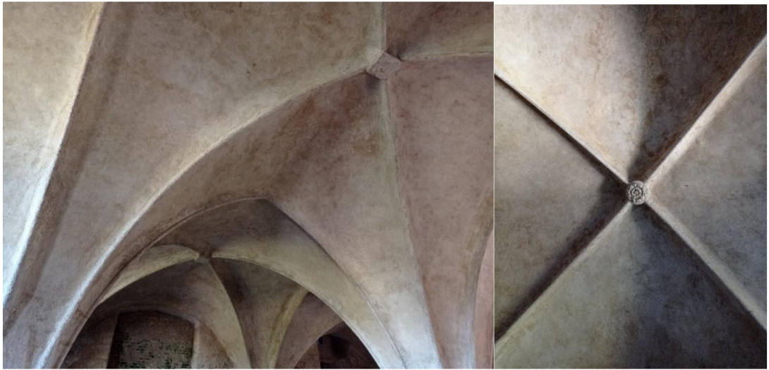
Obrázek č. 61: Klenba kaple Božího těla
