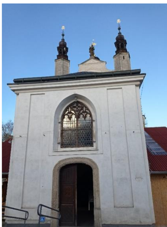
Obrázek č. 15: Předsíň – vchod do kostnice
