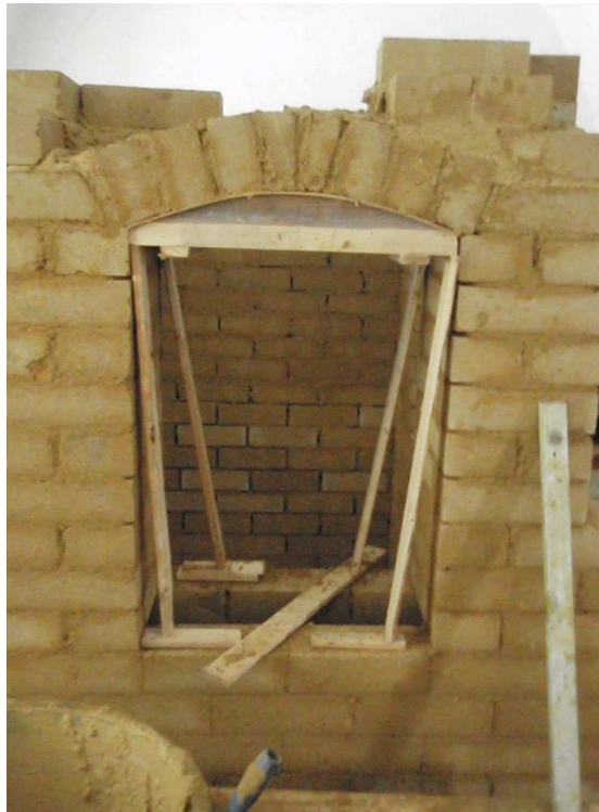
Obrázek 9 Stavba výklenku z hliněných cihel vii
