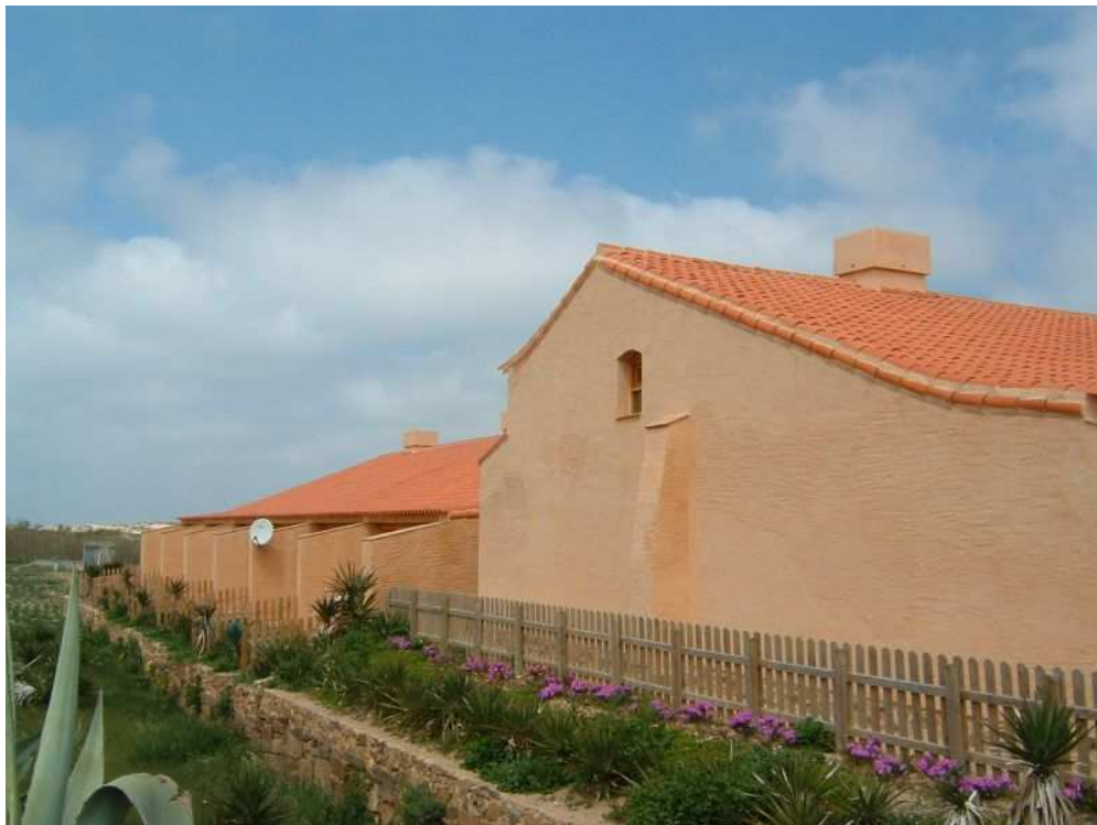
Obrázek 1 Dům omítnutý exteriérovou hliněnou omítkou
