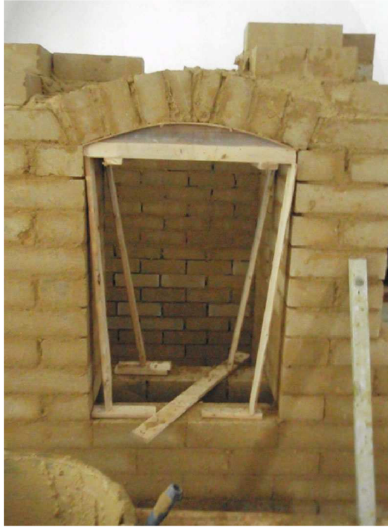
Obrázek 9 Stavba výklenku z hliněných cihel vii
