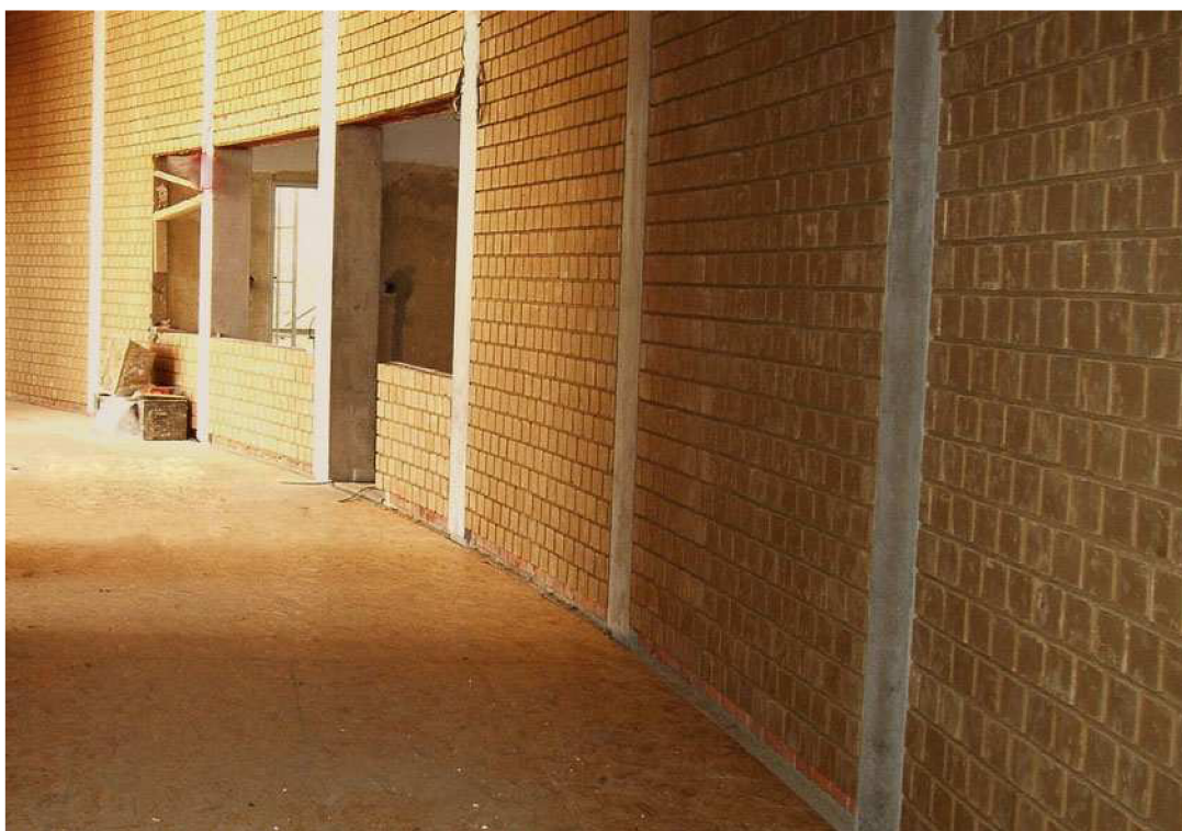
Obrázek 4 Část zdi, postavené z hliněných cihel ii
