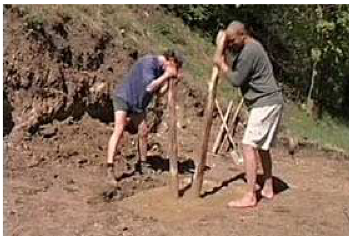
Obrázek 7 Tradiční způsob zpracování hliněných stavebních materiálů
