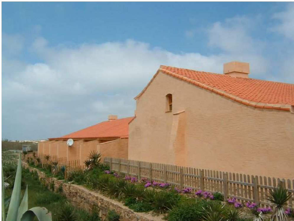
Obrázek 1 Dům omítnutý exteriérovou hliněnou omítkou
