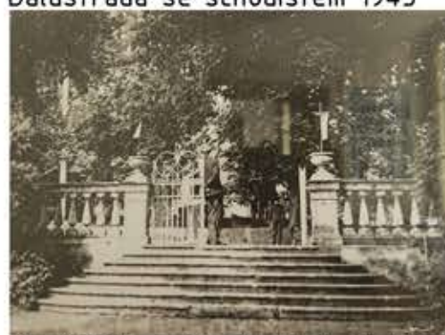
Obr. č. 26: Terasová zed' s balustrádami, která navazuje na jižní průčelí zámku, byla zřejmě přerušena oválným schodištěm s kovovou bránou ještě v roce 1945. Do dnešní doby se zachovaly pouze pozůstatky schodiště (Muzeum Kosmonosy).
