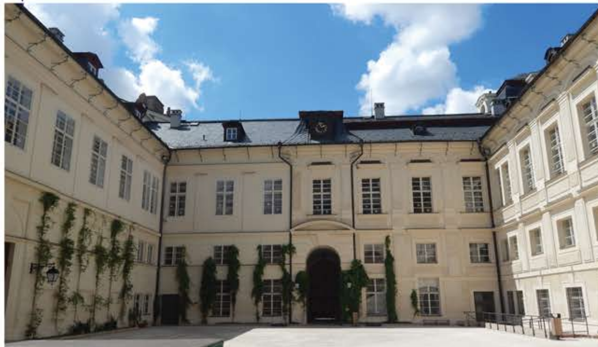
Obr. č. 54: Po vstupu na nádvoří se rozprostírá poměrně rozlehlý prostor. Omítky v této části zámku jsou opraveny a ozeleněny. Nádvoří pokrývá nová dlažba a také mobiliář je obnoven (foto autor).
