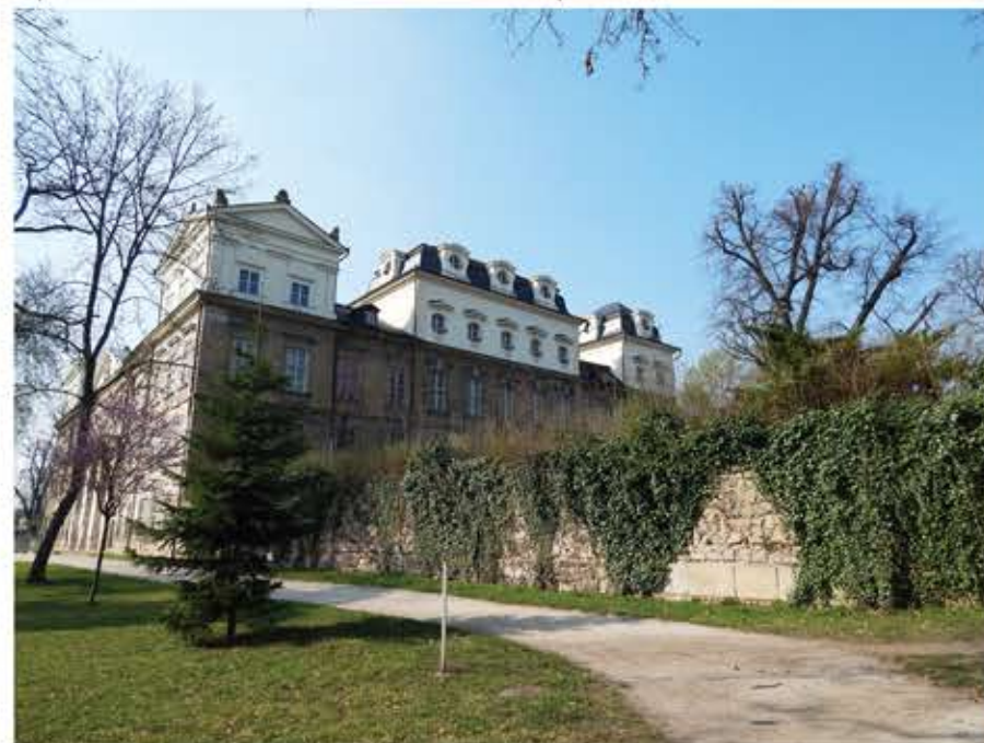
Obr. č. 40: Terasní zeď u zámku byla před její opravou v březnu 2014 popnutá břečťanem (foto autor).
