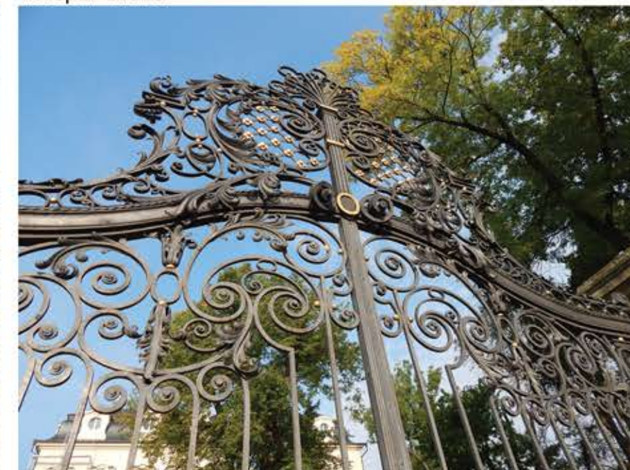
Obr. č. 41: Vstupní brána k zámku je ruční prací, je vyrobena z kovu a některé detaily jsou pozlaceny (foto autor).
