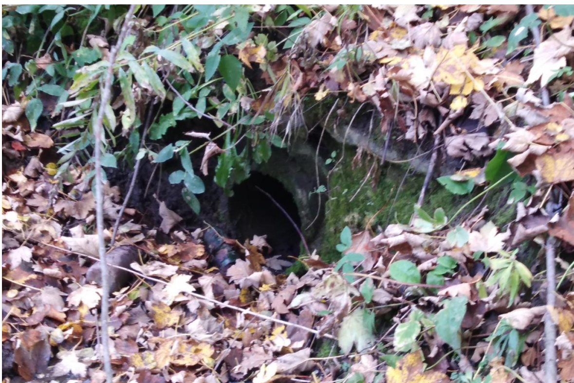
Obr.7.10 – Výpustné potrubí požeráku na vzdušném líci
