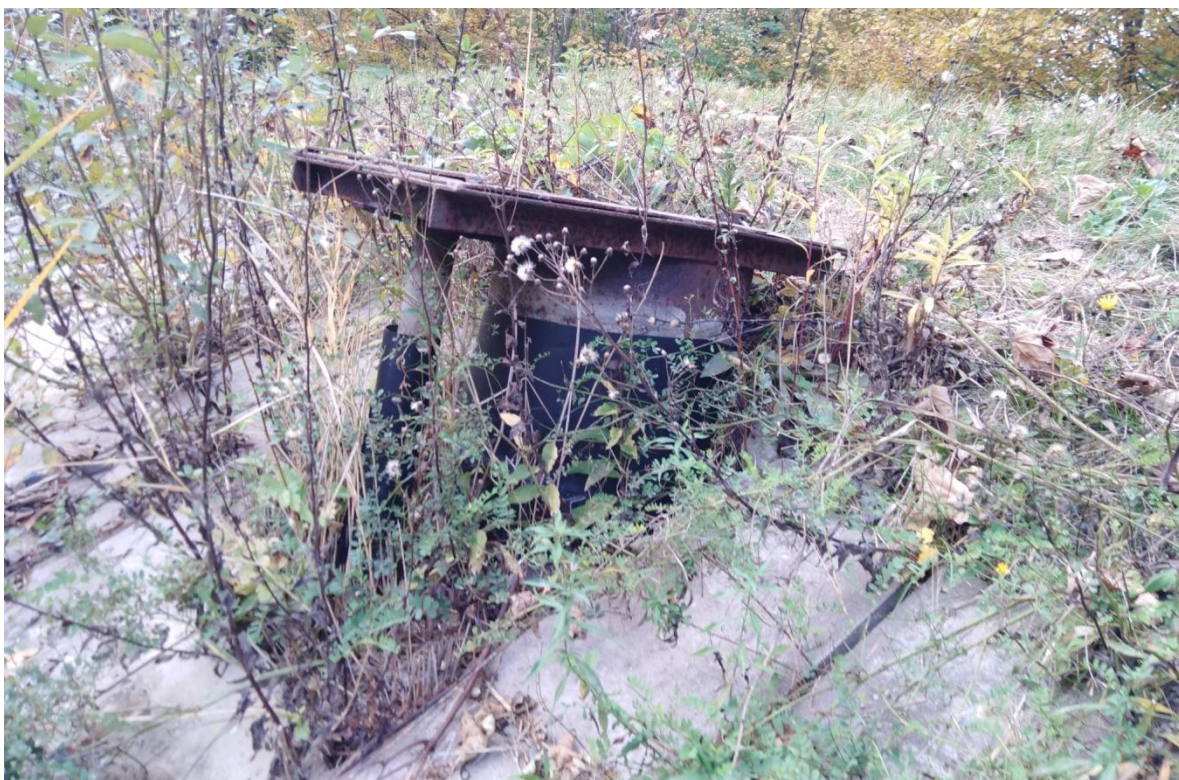
Obr.7.9 – Výpustný objekt (požerák)
