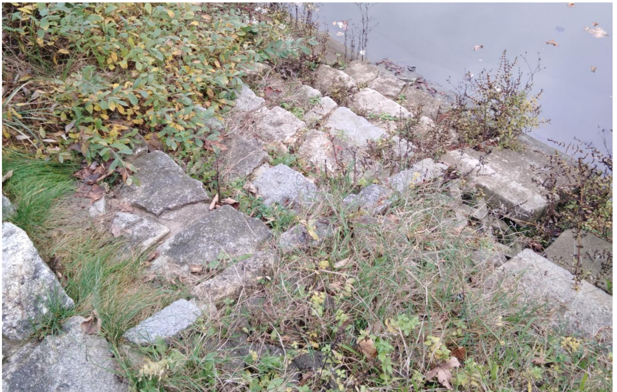
Obr.7.7 – Schody na návodním líci, součást bezpečnostního přelivu
