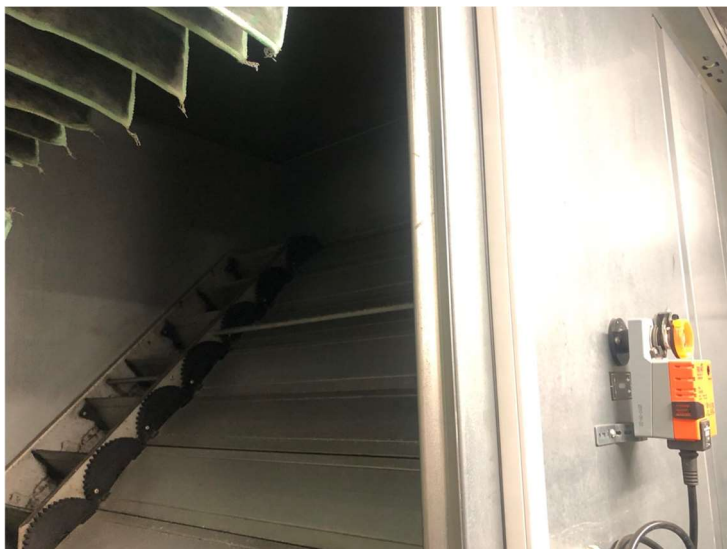
Obr. 15.4 – Deskový výměník [22]
