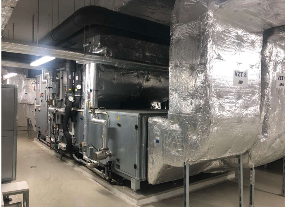
Obr. 15.2 – Měřená vzduchotechnická jednotka [22]
