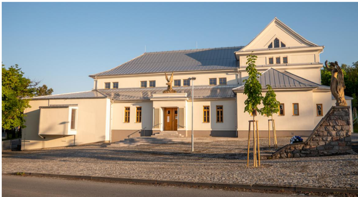
Fotografie 3: Budova konické sokolovny po dokončené rekonstrukci v roce 2019 – nyní sídlo KC
