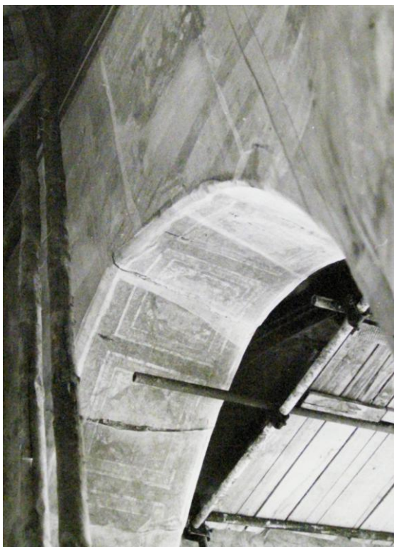
11. Vojtěchův sál – vstupní oblouk arkýře po připevnění odpadávajících přeletů, 1987.
