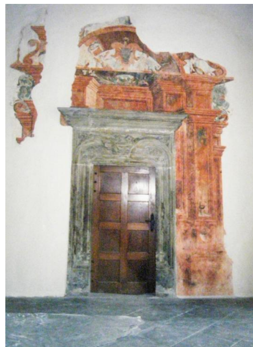
35. Mázhaus, tentýž portál, stav po rekonstrukci, zavádějící retuše byly odstraněny, 1995.
