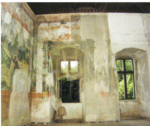
18. Vojtěchův sál – jižní stěna, stav před restaurováním, 1993.
