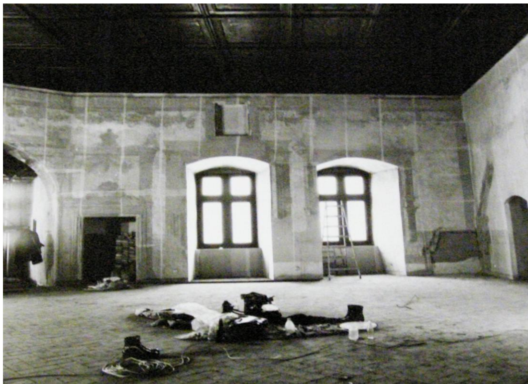
4. Vojtěchův sál, stav po instalaci přelepů, 1979.
