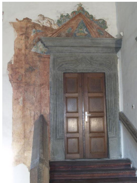
38. Mázhaus, portál v severní stěně, současný stav, 2008.
