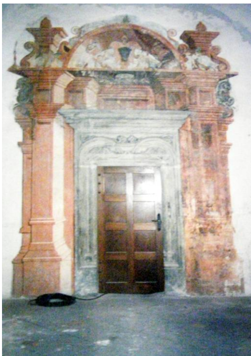
34. Mázhaus, portál ve východní stěně, stav před restaurováním. Domalby pocházejí ze 30. let, 1995.
