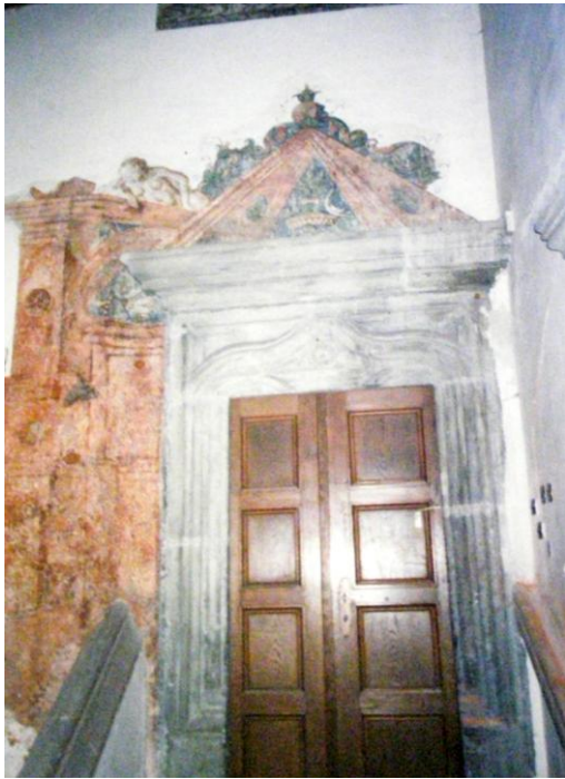
32. Mázhaus, malovaný portál u vchodu na severní stěně, stav před opravou, 1995.
