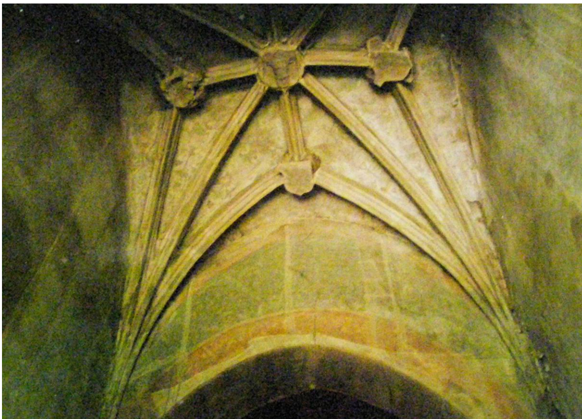
23. Vojtěchův sál – hvězdicová klenba arkýře pod přelepem, stav před restaurováním 1993.
