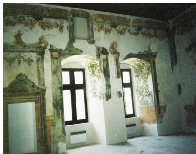
19. Vojtěchův sál – západní stěna, stav po restaurování, 1993.
