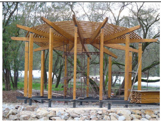
Obr. 16. J. Netík - stavba kaple (20.10.2009)
