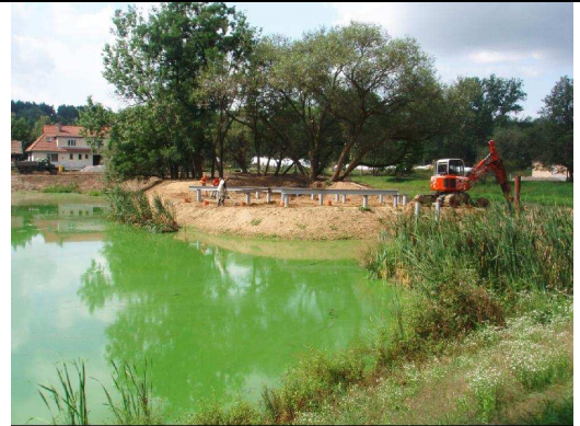
Obr. 12. J. Netík - stavba kaple (14.7.2009)
