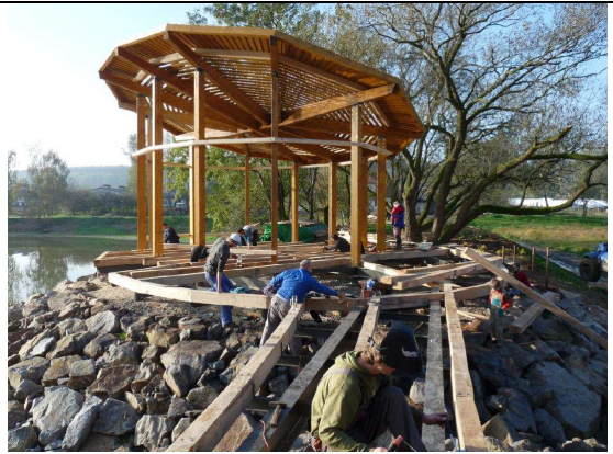
Obr. 18. J. Netík - stavba kaple (24.10.2009)
