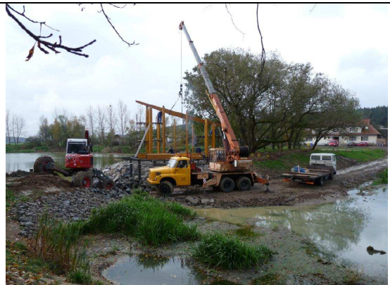
Obr. 14. J. Netík - stavba kaple (14.10.2009)
