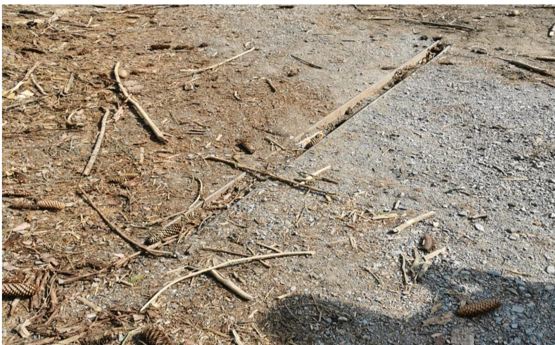
Obr. 12 – Zanesená svodnice vody
