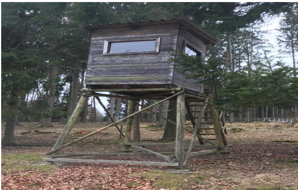
Obr. 10 – Kazatelna s pultovou střechou
