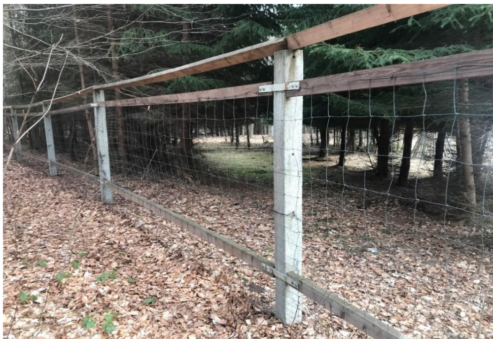
Obr. 4 – Oborní plot z pletiva a modřínových latí
