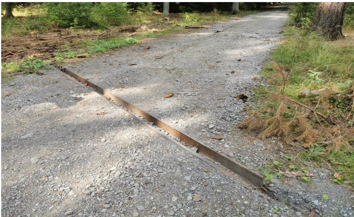
Foto – Svodnice vody
