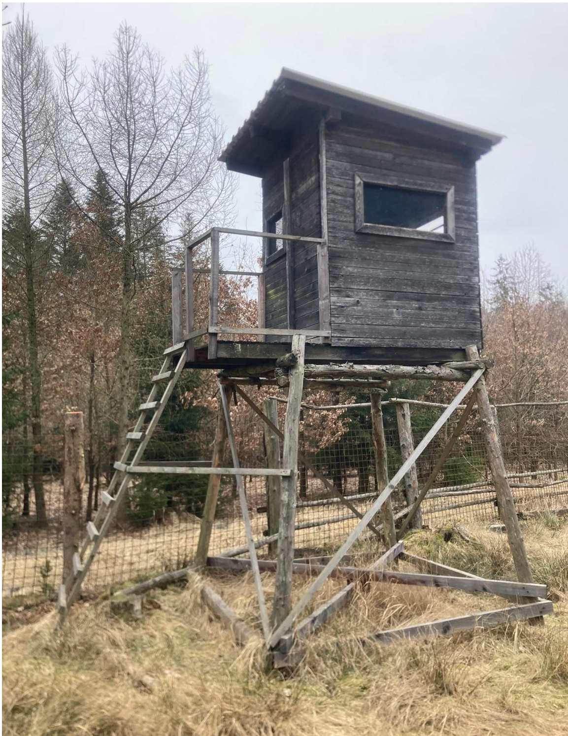
Obr. 10 – Kazatelna s pultovou střechou
