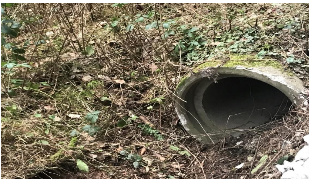
Foto – Betonový propustek
