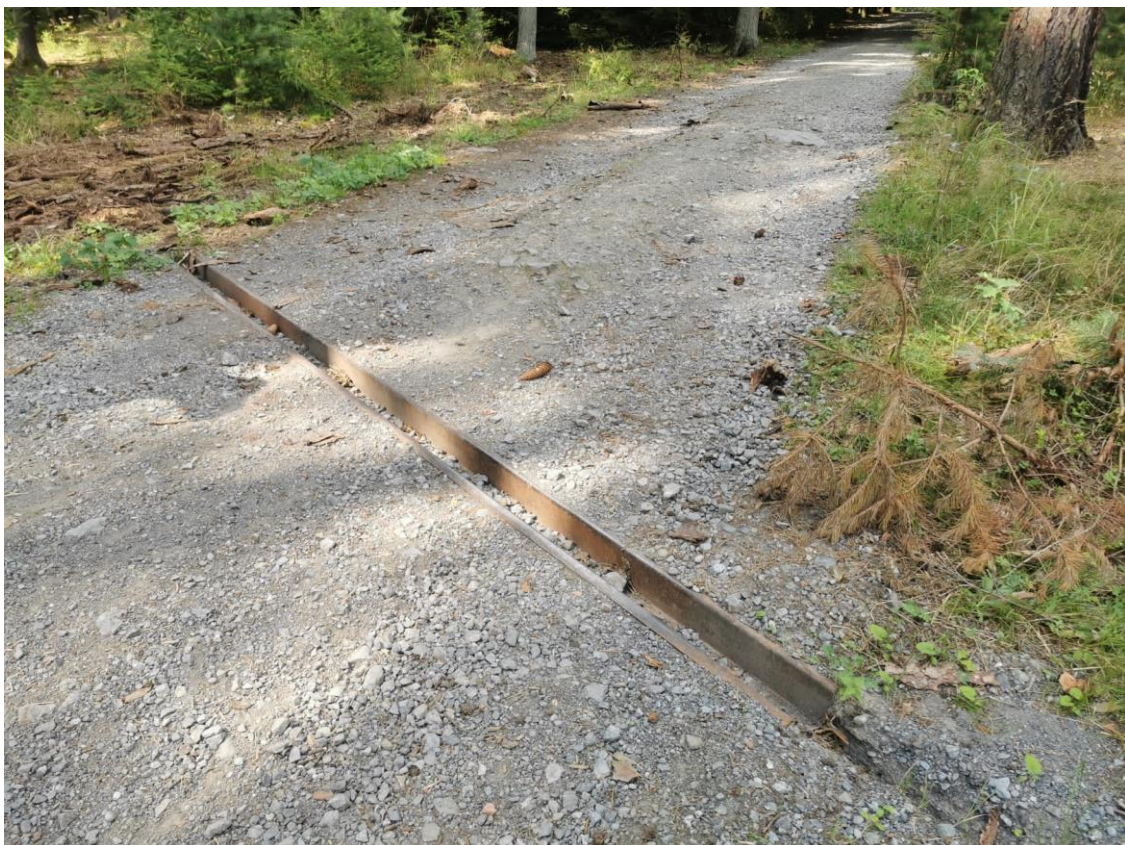
Obr. 11 – Udržovaná svodnice vody
