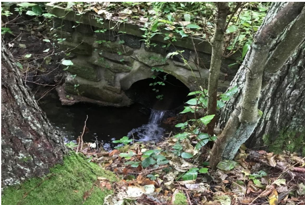
Foto – Propustek s čelem z čediče
