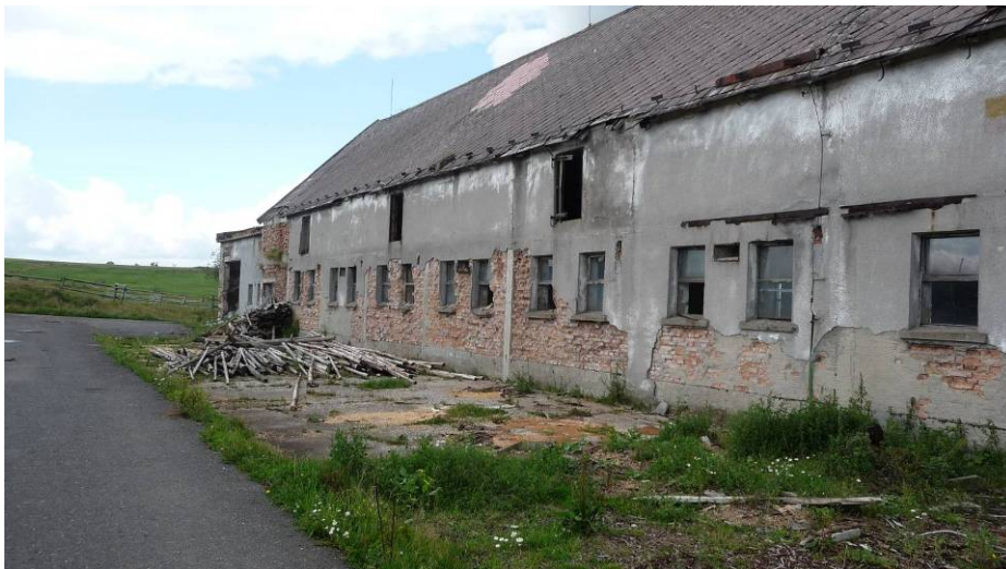
Foto č. 2 SO-01 - JJV pohled, vstup do kravína, konec objektu se seníkem
