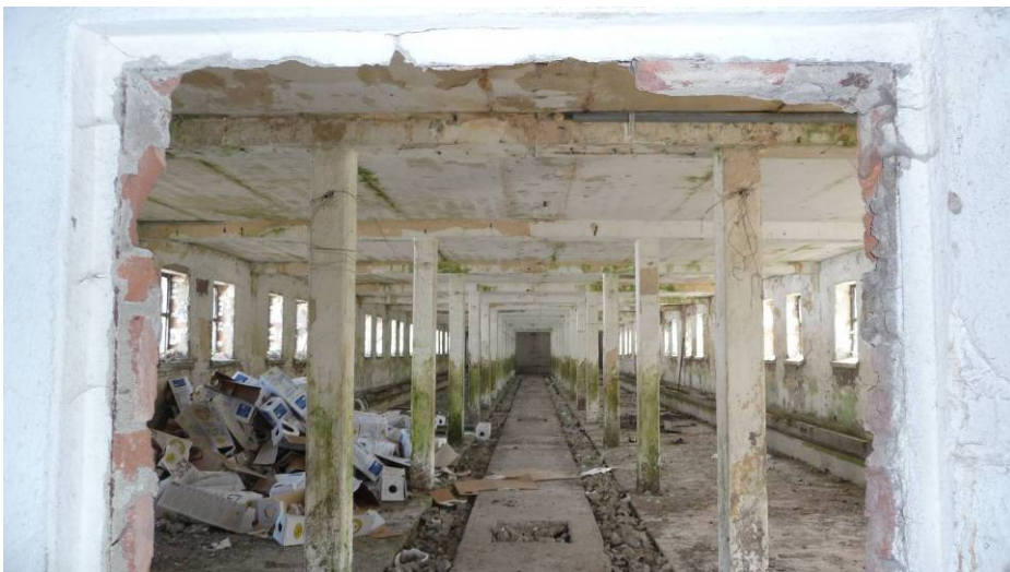
Foto č. 6 SO-01 - Středová chodba kravína
