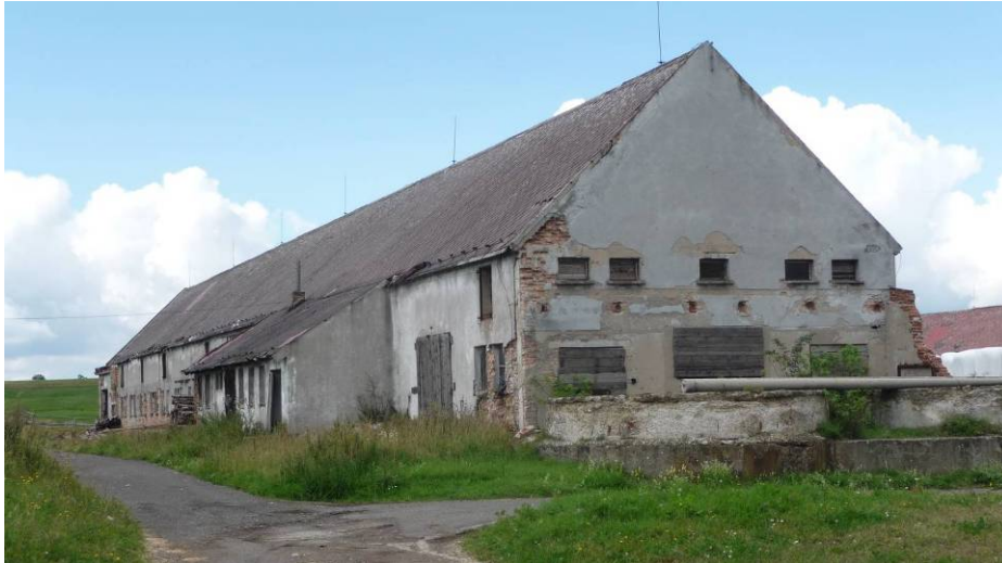
Foto č. 1 SO-01 - JV pohled, vstupy
