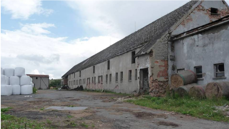
Foto č. 5 SO-01 - SSZ pohled na kravín se vstupy
