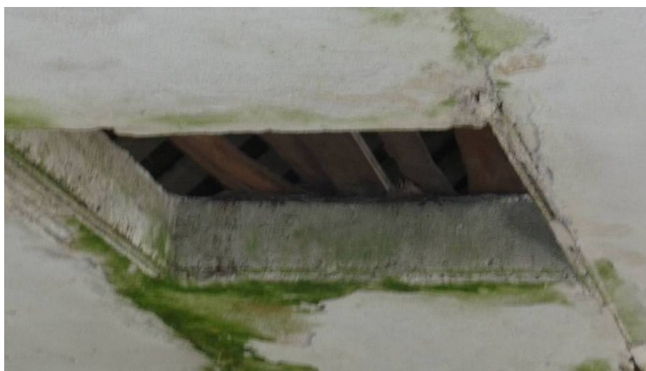
Foto č. 10 SO-01 - Větrací otvor a schoz z půdního prostoru
