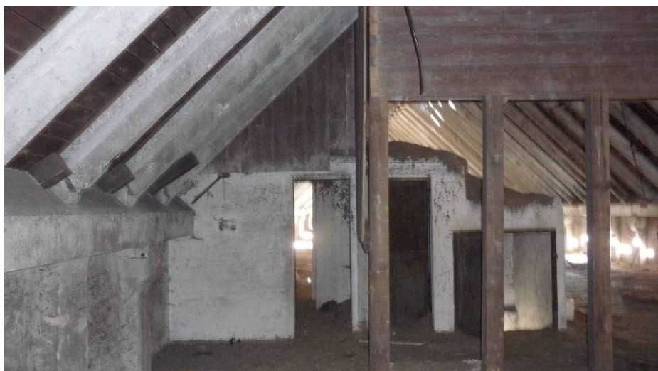
Foto č. 9 SO-01 - Krov z betonových prefabrikátu, s krytinou z cemento- vláknitých šablon
