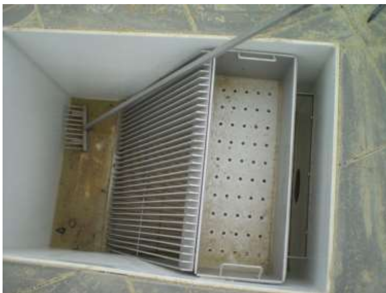
Obr. 7 Ručně stírané česle ( www.asio.cz )
