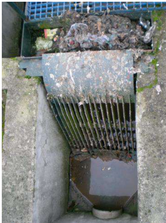
Obr. 10 Ručně stírané česle (Jan Vymazal)
