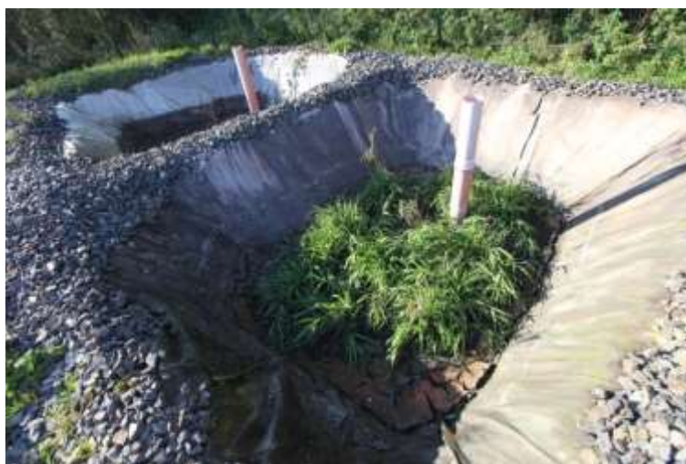
Obr. 13 Štěrbínová usazovací nádrž [5]
