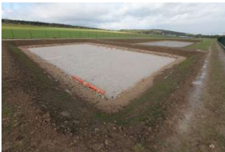
Obr. 29 Horizontální filtr s dvěma průtoky (Michal Křiška-Dunajský)
