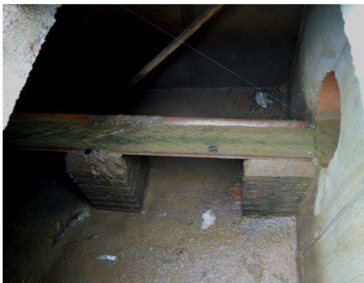
Obr. 11 Odlehčovací komora (Jan Vymazal)
