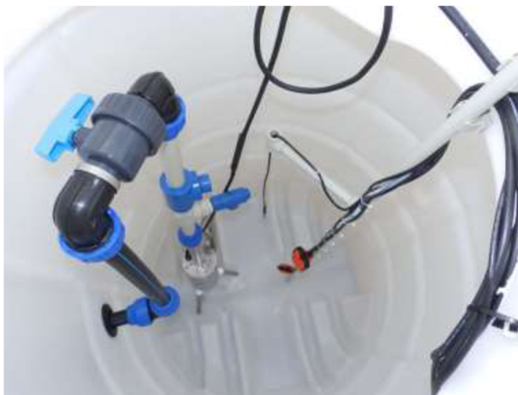
Obr. 5 Čerpací jímka tlakové kanalizace ( www.cerpacijimky.cz )
