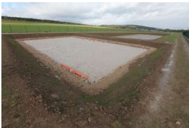
Obr. 29 Horizontální filtr s dvěma průtoky (Michal Křiška-Dunajský)
