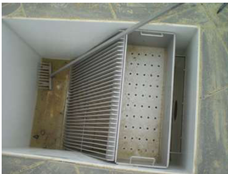
Obr. 7 Ručně stírané česle ( www.asio.cz )
