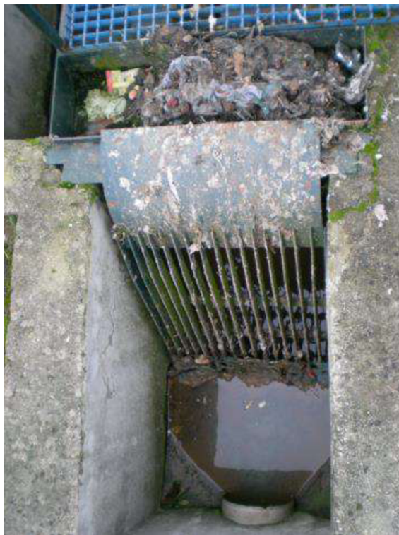
Obr. 10 Ručně stírané česle (Jan Vymazal)
