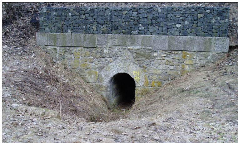
Obr. 5: Tunel pod železniční tratí – vchod směřující k silnici. Foto: autorka.
