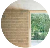
nosné betónové murivo v kombinácii so železobetónovým stropom
