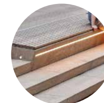
g.) betónové stupne na sedenie s osvetlením
