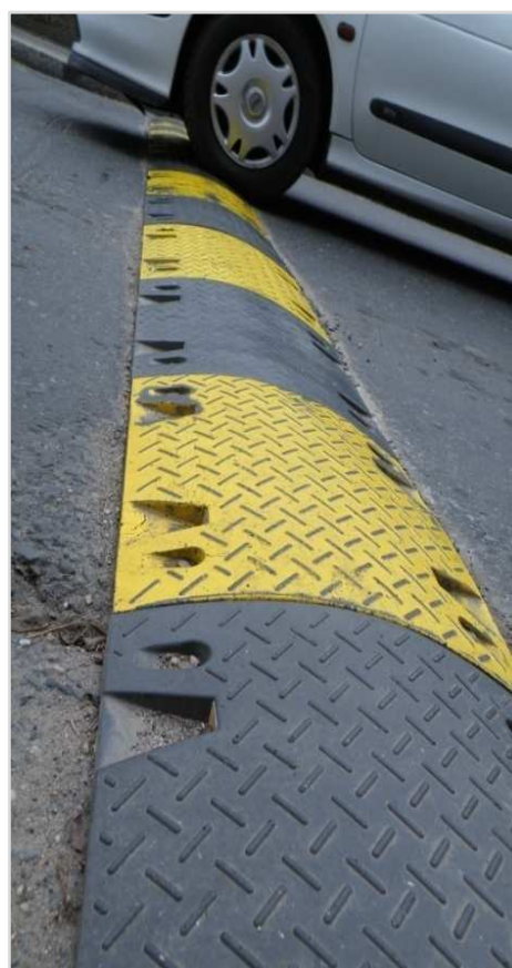
Obr. 16 Příčný zpomalovací práh z montovaných dílců
