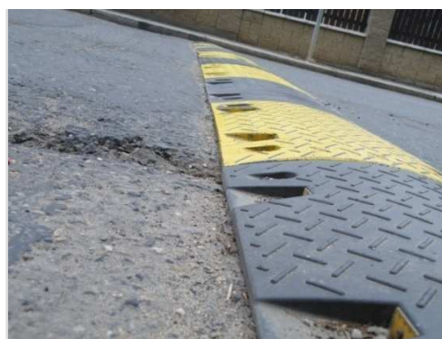
Obr. 17 Struktura povrchu vozovky
