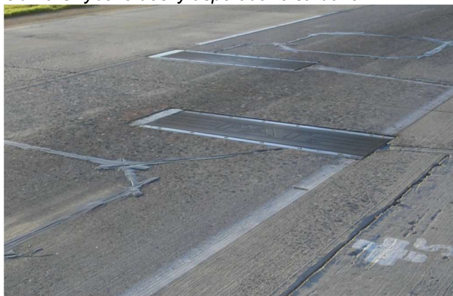
Obr. 9 Ohybové desky uspořádané střídavě
