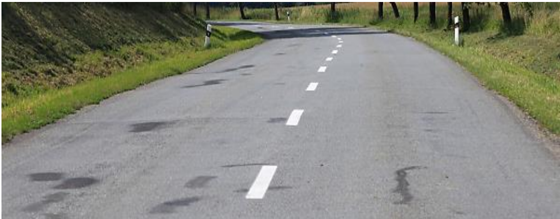
Obrázek 19 - Ukázka vyhovujícího stavu komunikace [10]
