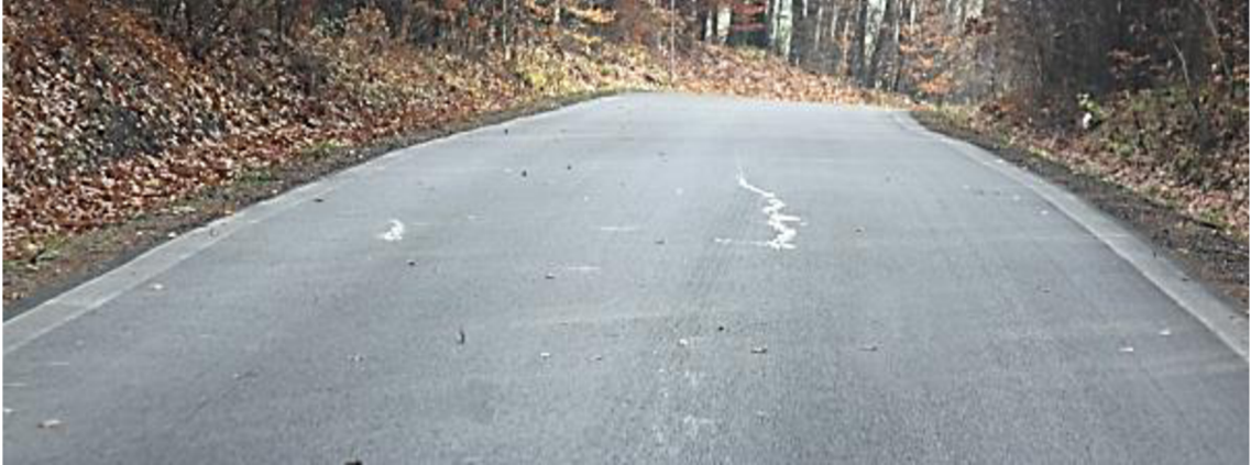
Obrázek 18 - Ukázka dobrého stavu komunikace [10]
